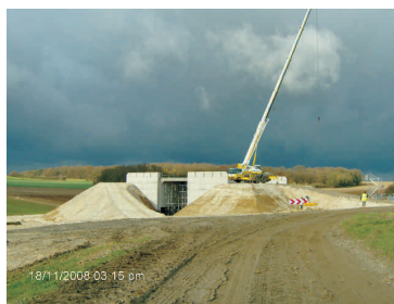
Construction de l'Ouvrage d'art N°2
