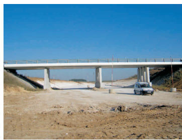
Ouvrage d'art N°5
