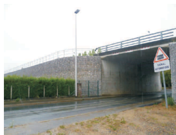
Mur de soutènement à proximité de l'ouvrage d'art N°0 existant
