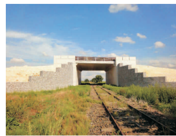
Ouvrage d'art N°7 achevé
