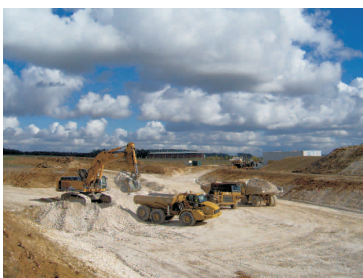
Terrassement section courante
