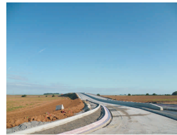
Barreau -G4-G5 et pont sur la voie ferrée
