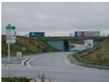
Le projet a consisté à déniveler la route départementale. La RD172 passe désormais sous la RN2 mise à 2x2 voies par l'intermédiaire d'un pont qui a été construit en deux temps afin de maintenir la circulation sur la RN2 pendant les travaux. De part et d'autre du pont, deux giratoires ont été créés sur la RD172. Les 4 bretelles d'entrées et sorties de la RN2 viennent s'y rattacher.
