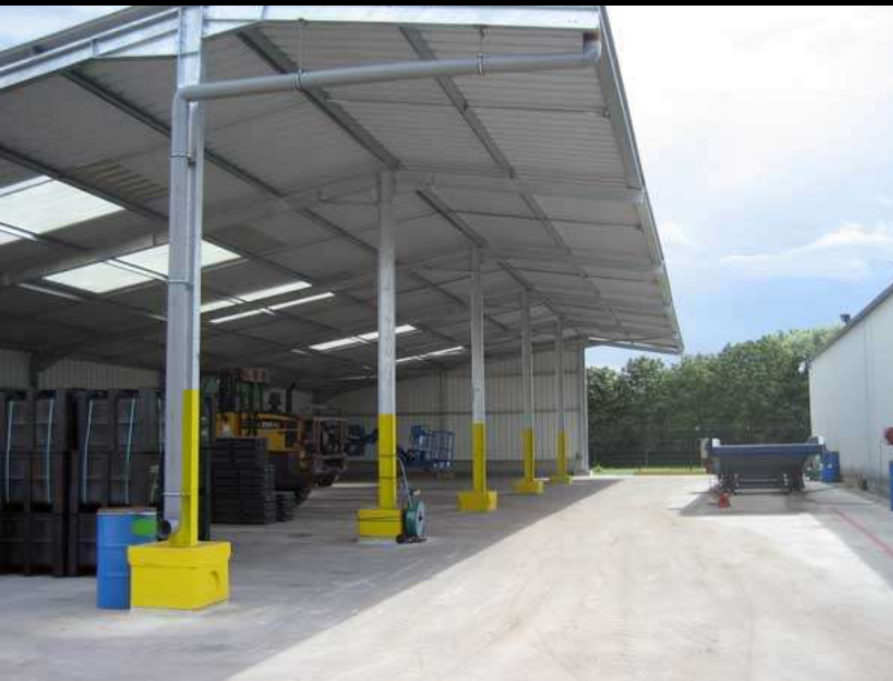
Hangar de stockage « Export »
