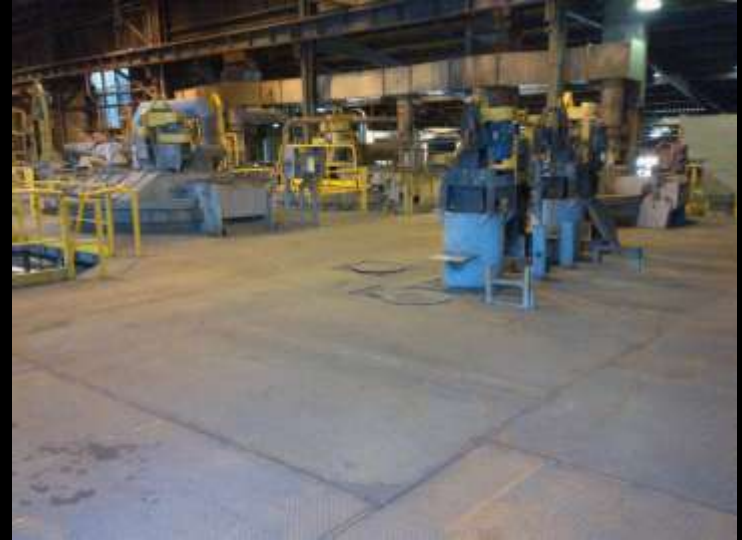
Réfection Plateforme Affinage
