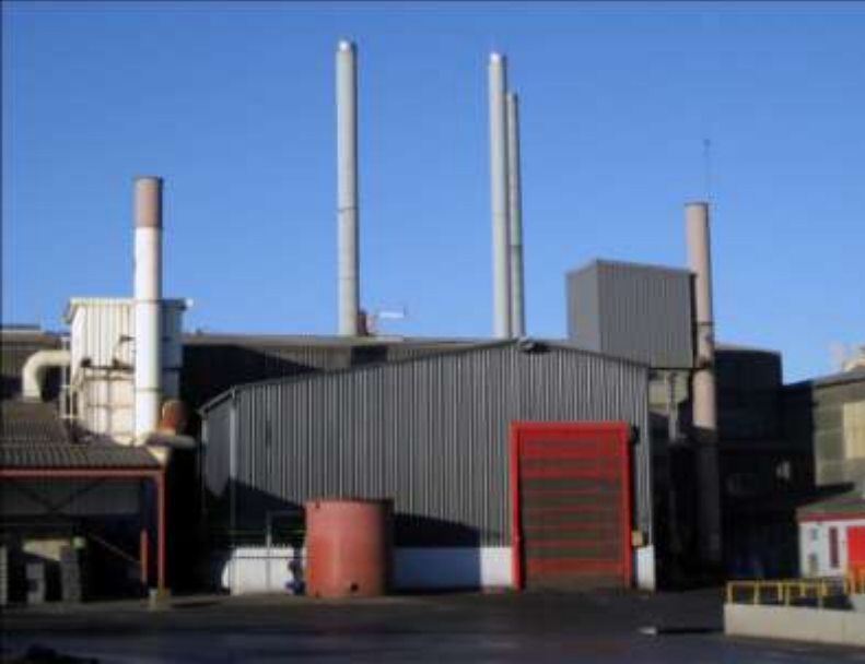
Réfection du bâtiment « scories »
