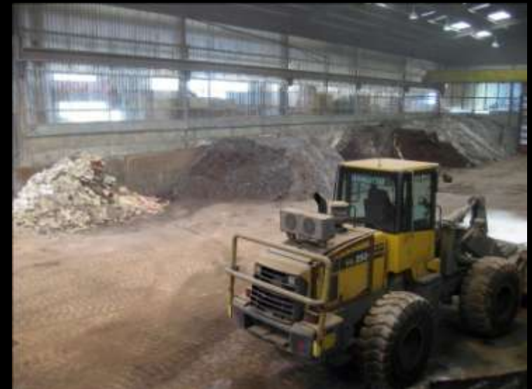
Réfection bardages Hall Matières
