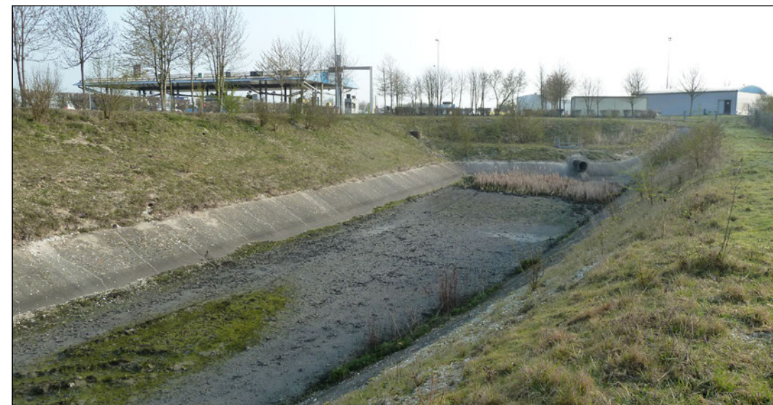
Photo 15 : Bassin de rétention situé en bordure de la barrière de péage
