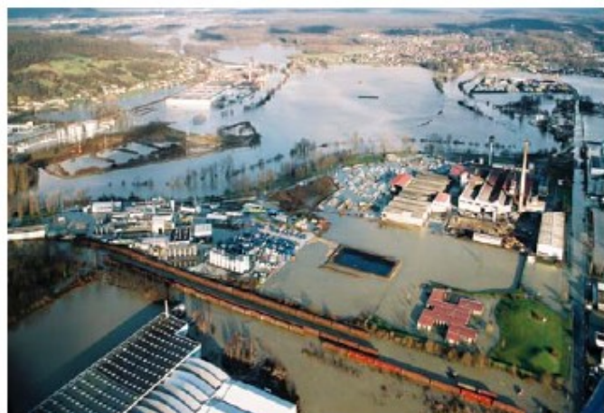
Crue de l'Oise et l'Aisne en décembre 1993 confluence Aisne-Oise à Choisy au Bac,
