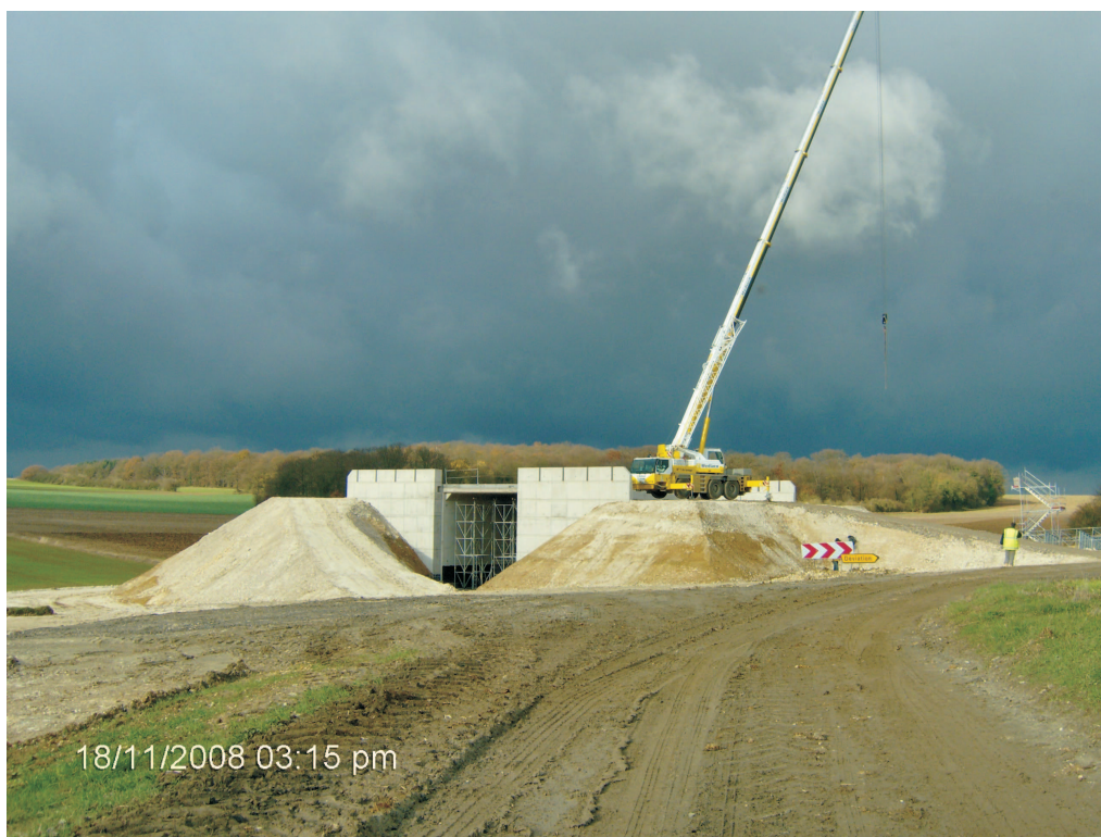
Construction de l'ouvrage d'art N°2
