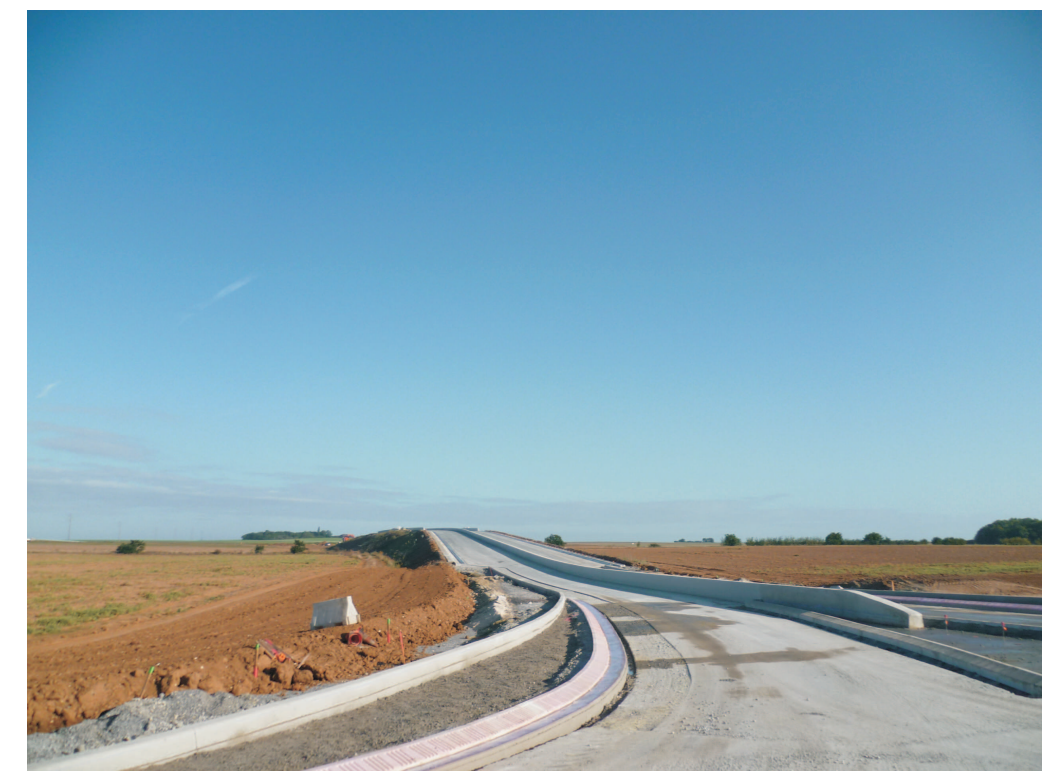
Barreau -G4-G5 et pont sur la voie ferrée
