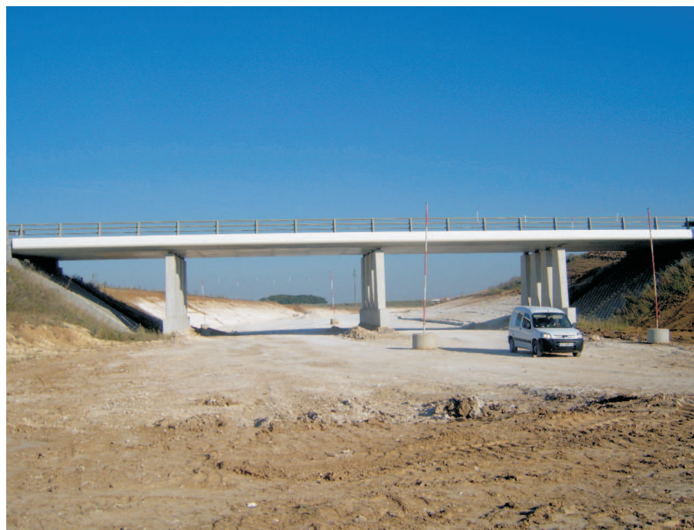
Ouvrage d'art N°5
