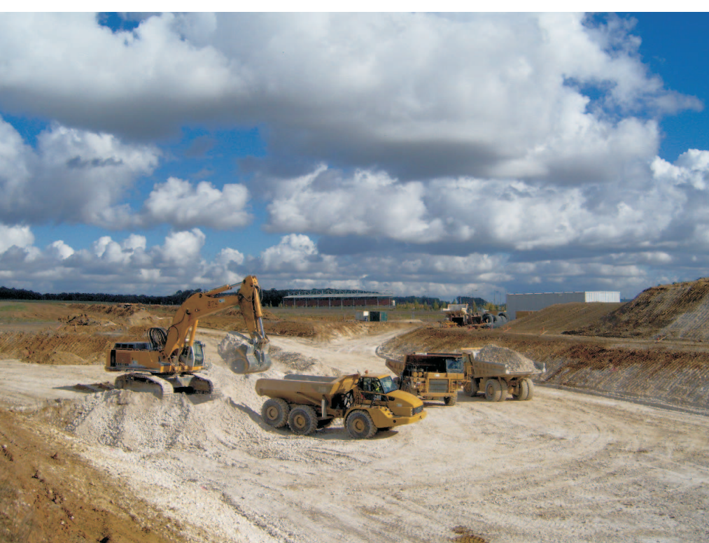
Terrassement section courante
