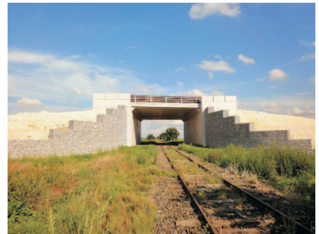
Ouvrage d'art N°7 achevé
