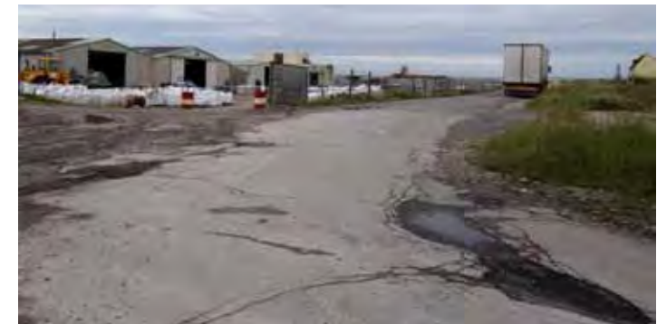
Maîtriser les extensions bâties : veiller au positionnement et à la qualité des zones d'activités. Cayeux-sur-Mer
