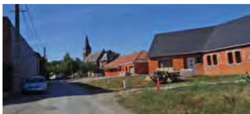
Mieux harmoniser l'urbanisation récente avec les implantations bâties du centre bourg. Friscamps
