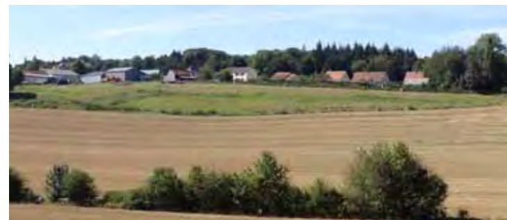
Maîtriser la périphérie des villages afin d'éviter d'offrir en premier plan les hangars en tôles et les nouvelles constructions qui masquent la qualité patrimoniale du bâti. Courcelles-sous-Moyencourt
