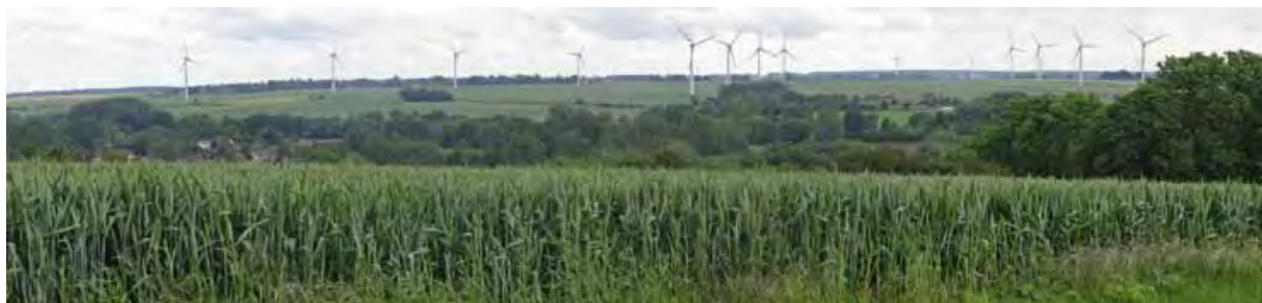
Eviter une domination visuelle excessive des parcs éolien sur le paysage de la vallée. Maisnières
