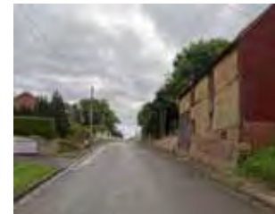
Un patrimoine bâti mêlant pierre, brique et torchis. Hérissart
