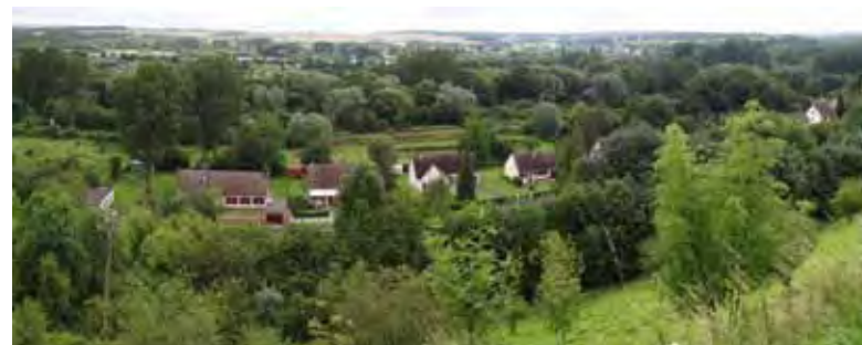
Inscrire les extensions bâties dans la continuité des formes urbaines existantes. Hangest-sur-Somme
