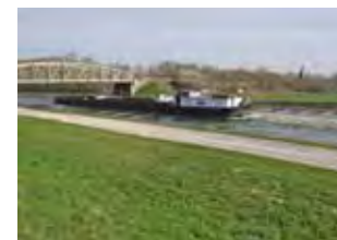
Le canal passe à proximité des villages, signalé par un ouvrage de franchissement. Buvérchy
