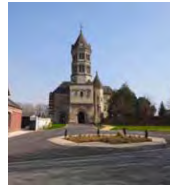
Mettre en valeur les abords des église en évitant l'enrobé banal. Monchy-Lagache
