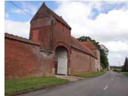
La présence d'un patrimoine de grosses fermes aux abords de la vallée de l'Authie. Couin
