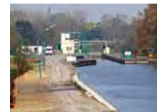
21 écluses jalonnent le parcours du Canal du Nord. Languevoisin-Quiquery
