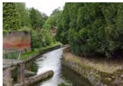
Éviter le cloisonnement des abords du cours d'eau par des résineux. Heilly
