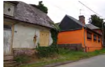
Eviter les restaurations anachroniques et aider la restauration du bâti ancien. Béhencourt
