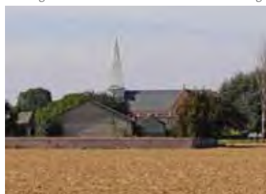
Maintenir et encourager la préservation du patrimoine bâti ancien ou plus récent. Bouchoir
