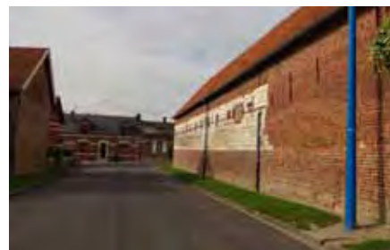
Un bon exemple de traitement des trottoirs qui met en valeur le bâti ancien. Hailles
