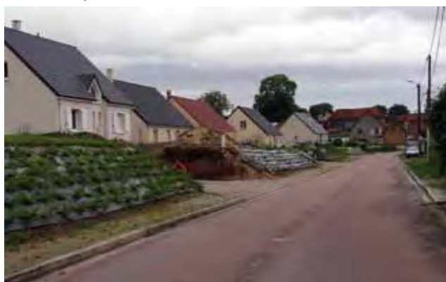
Requalifier l'espace public et revoir les règles d'urbanisme pour améliorer l'insertion des prochaines constructions. Métigny
