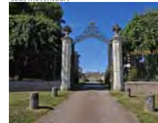
Un patrimoine bâti de grands domaines et de châteaux du XVIIIe siècle. Courcelles-sous-Moyencourt
