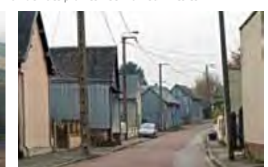
Rénover le patrimoine bâti des villages. Beaucamps-le-Vieux
