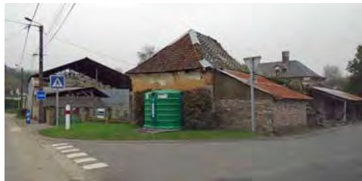
Sauvegarder le patrimoine bâti du cœur de village. Limeux
