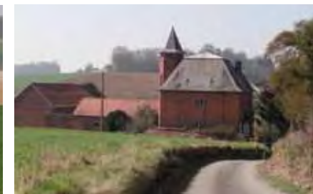
Un patrimoine de fermes de la reconstruction en périphérie des villages. Templeux-la-Fosse
