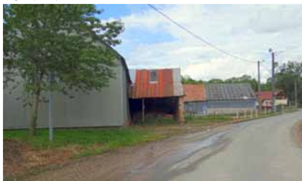
Soigner le patrimoine bâti le plus caractéristique des villages. Ercourt
