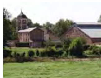
Un patrimoine remarquable « brique et pierre » : ferme et pigeonnier hexagonal. Cayeux-en-Santerre
