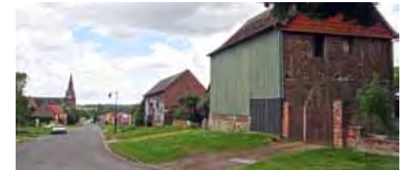
Inciter et aider l'entretien du bâti de grange sur rue qui pénalise la rue principale du village. Fréchencourt
