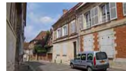
Pierre et briques en mélange dans les faubourgs. Clermont
