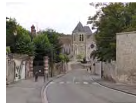
Améliorer la qualité des traversées de bourg en leur donnant un caractère de rue plutôt que de route comme sur cette photo. Betz
