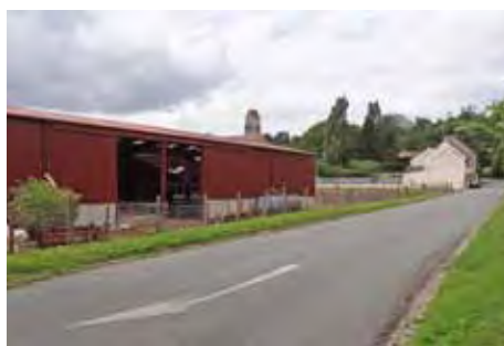
Attention au positionnement des nouveaux hangars agricoles en entrée de bourg qui masquent le village. Rosoy-en-Multien
