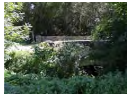
Rouvrir le fond de vallée et mettre en valeur les ouvrages d'art. Lavilletterte
