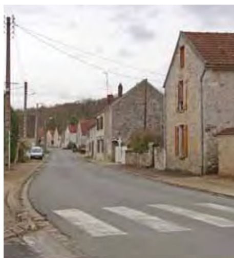
Conservier l'esprit villageois en s'inspirant de l'implantation des maisons, avec pignon sur rue. Aménager simplement les rues en gardant un vocabulaire rural. Varinfroy
