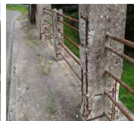
Veiller à l'entretien des ouvrages d'art liés au canal. Chiry-Ourscamps
