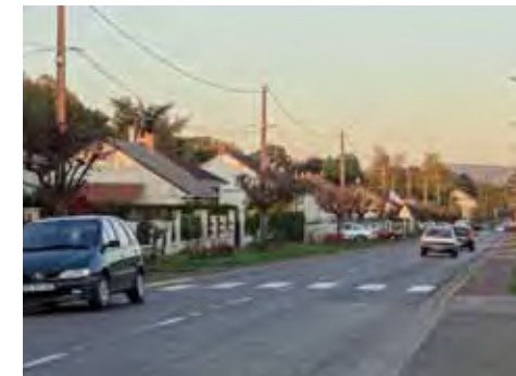
Eviter l'urbanisation linéaire qui plante les habitations le long d'une route, et non d'une rue, loin du centre bourg comme ici à Saint-Aubin-en-Bray
