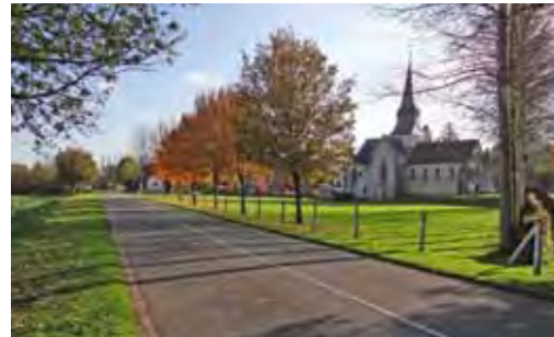
Des centres bourgs harmonieux : alignements d'arbres accompagnant la route, traitement simple mettant en valeur l'église. Fontenay Torcy
