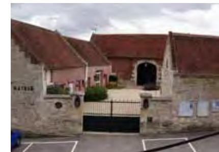
De grandes fermes à cour carrée. Pronleroy
