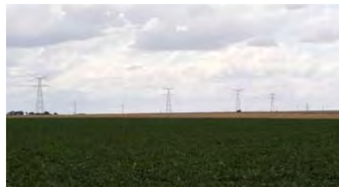
Etre vigilant sur les impacts visuels des réseaux aériens et des mât ou antennes, visibles de très loin. Angivillers
