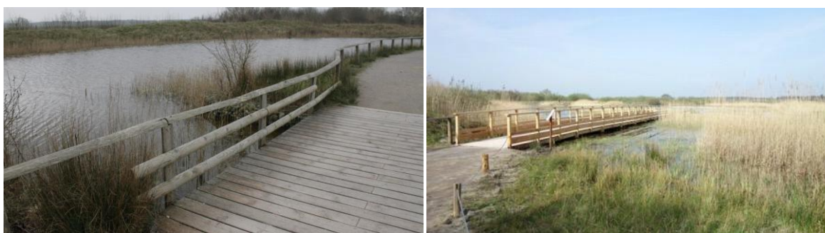
Figure 35 : Remise à neuf d'une passerelle dans le Parc ornithologique (avant/après)
