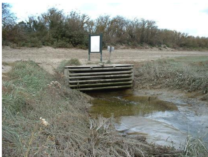
Figure 10 : Vanne de la digue
