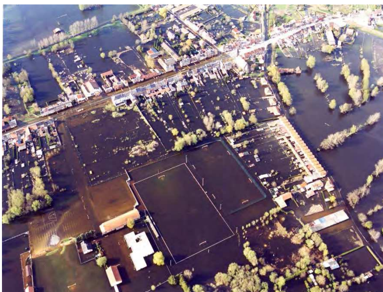
Figure 13 : Abberville inondée par la crue de la Somme du printemps 2001. [Sources : Photos aériennes crue Somme Mai 2001, DIREN Picardie]
