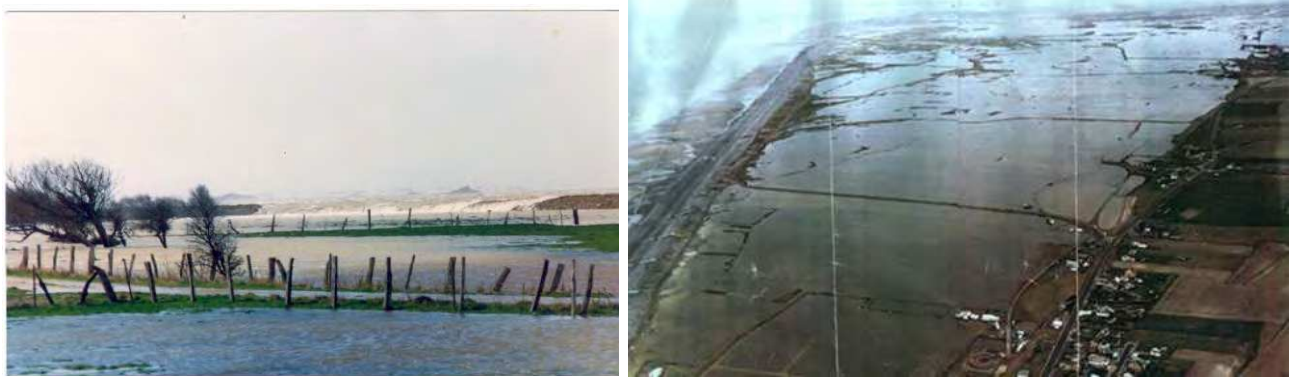
Figure 3 : A gauche, digue des Bas-Champs submergée et érodée en pleine tempête [Source : cayeux-citoyens.asso-web.com]. A droite, vue aérienne de cette zone totalement remplie par les eaux [Source : Le littoral des Bas-Champs soumis aux risques perpétuels d'inondation]
