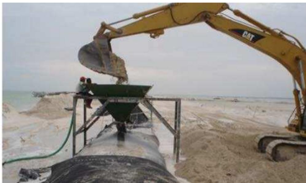
**Figure 21 - remplissage d'un tube en géotextile**
