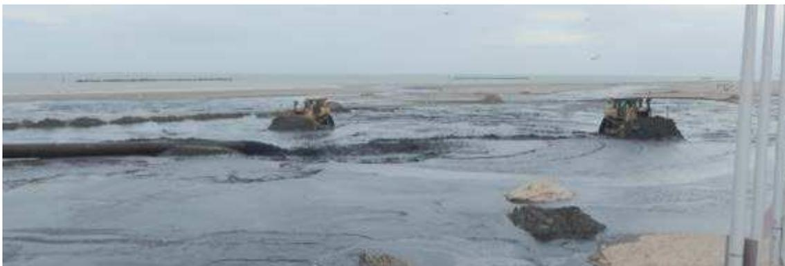
**Photo 19 - Régalage du sable et reprofilage de la plage (EGIS, rechargement de la Digue des Alliés, 03/2014)**
