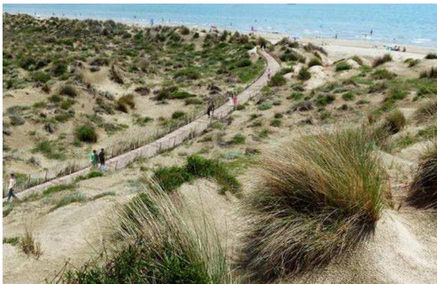
**Figure 10 : Exemple d'accès aménagé à l'aide d'un platelage composé de lattes de bois.**
