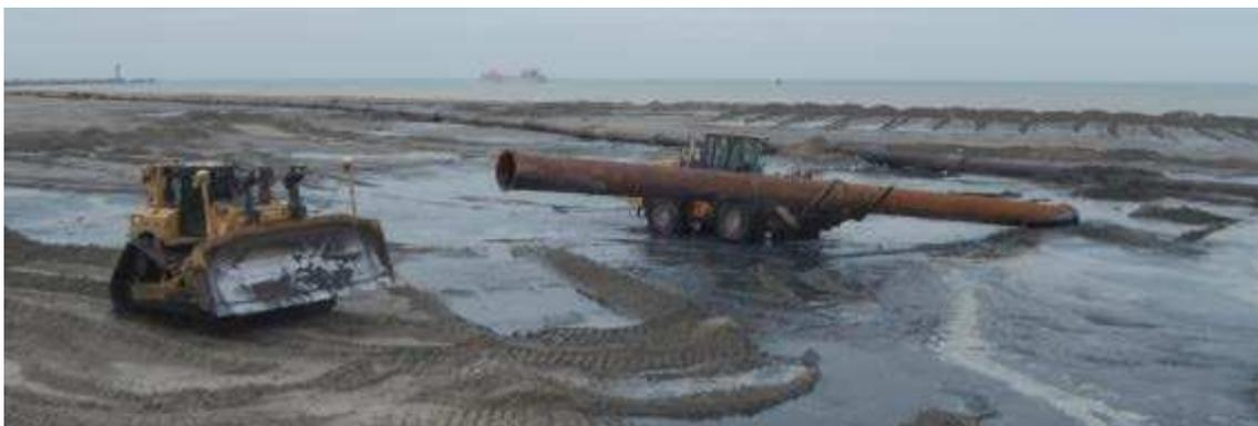
**Photo 17 - Préparation de la conduite à terre (EGIS, rechargement de la Digue des Alliés, 03/2014)**
