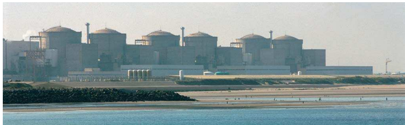
La centrale nucléaire de Gravelines.
