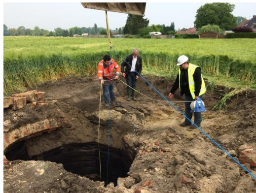
Figure 3 - Mesure de niveau d'eau
