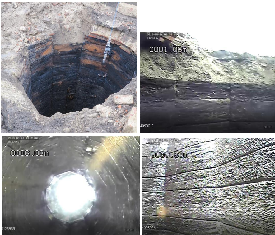
Figure 4 - Cuvelage en bois en partie haute : bon état général, forme décagonale, éléments jointifs, suintements et trainée ocre d'écoulement d'eaux chargées. (Photos UTAM Est)
