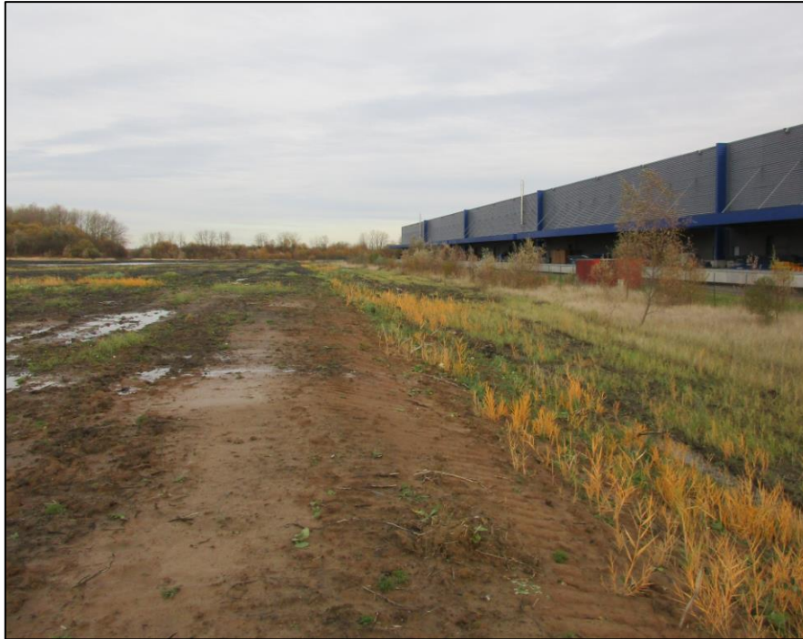
Figure 4 : Photographie (vue 1 de la Figure 3) de la partie sud du terril 117 au niveau du bâtiment de la société DELTA 3 (cliché GEODERIS, 22/11/2016)
