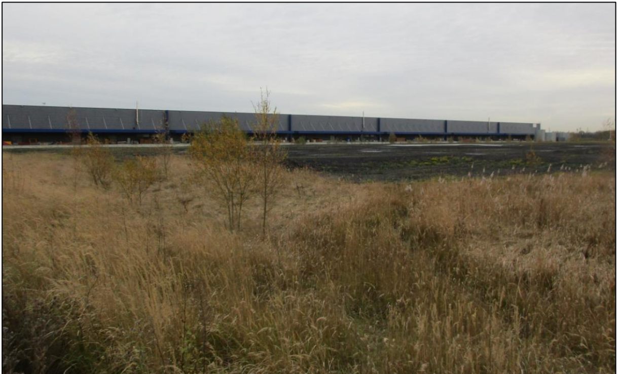
Figure 5 : Photographie (vue 2 de la Figure 3) d'ensemble de la partie du terril arasée avec les restes de matériaux schisteux (cliché GEODERIS, 22/11/2016)
