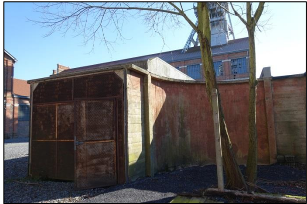
Figure 4 : Entrée de la galerie à proximité du puits n°2
