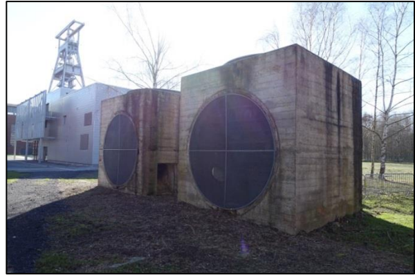
Figure 8 : Ventilateurs vus de l'extérieur
