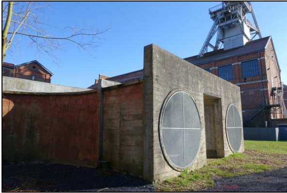
Figure 7 : Ventilateurs vus de l'extérieur
