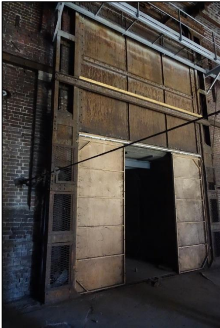
Figure 3 : Entrée de la galerie depuis le puits n°1
