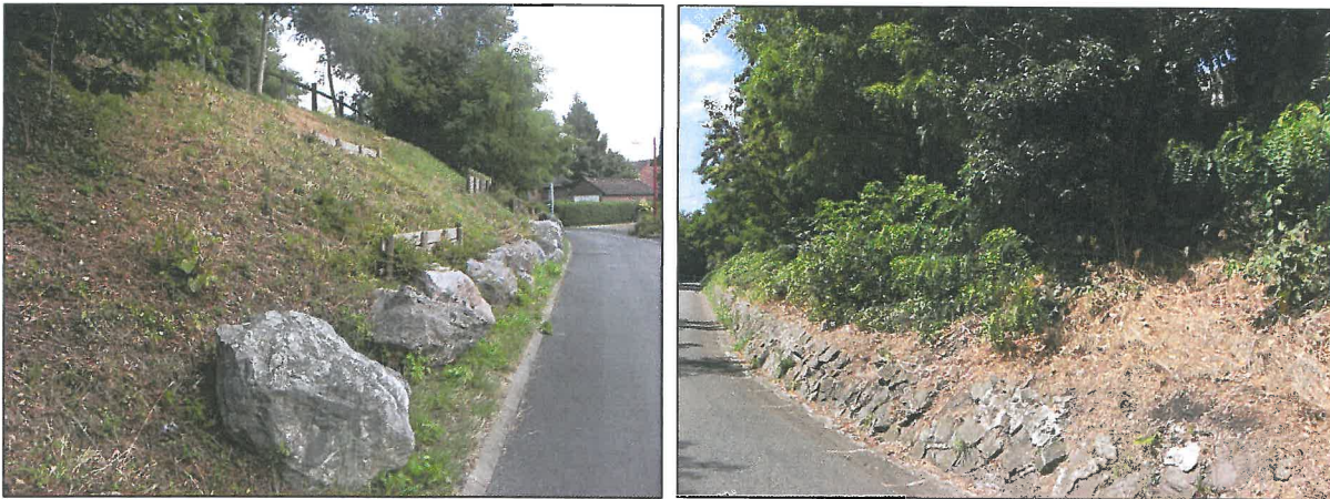
Figure 8 : Pente du terril du côté sud
