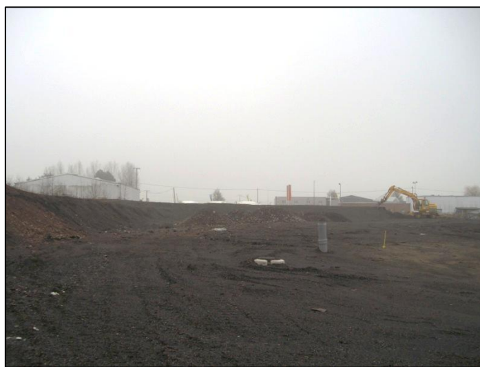
Figure 12 : Partie actuellement en travaux
