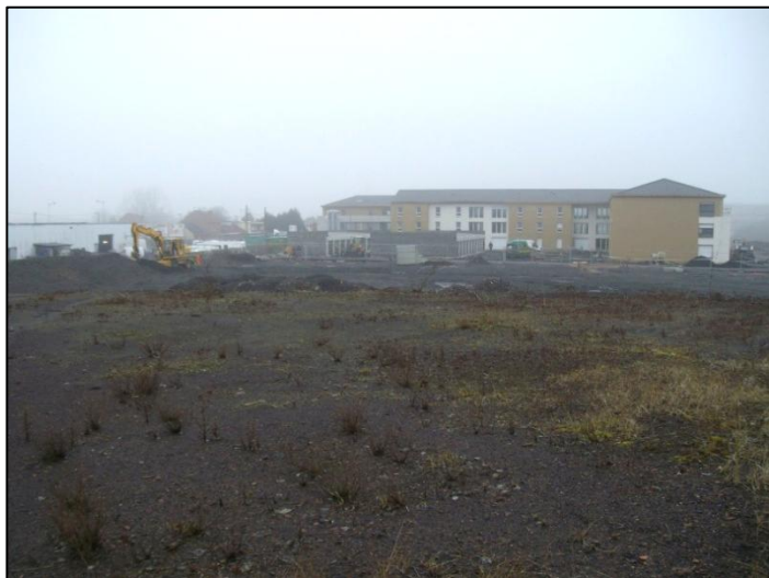
Figure 10 : Zone de replat
