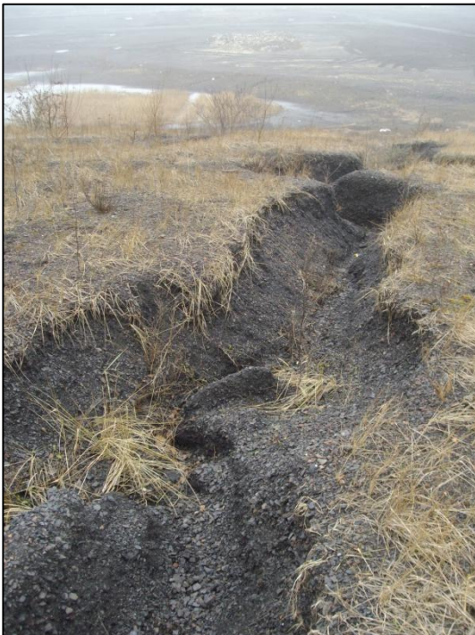
Figure 4 : Ravine dans le flanc nord-ouest du terril
