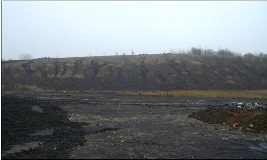
Figure 3 : Ravinement dans le flanc nord-ouest du terril
