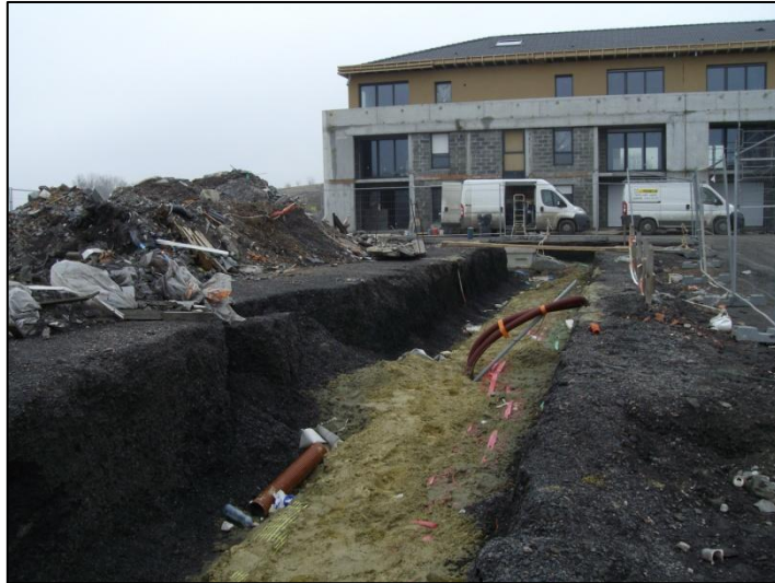
Figure 13 : Tranchée à proximité des bâtiments construits
