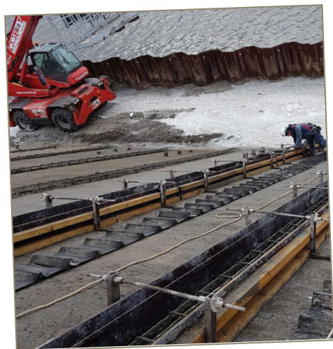
Travaux de confortement de la digue des alliés à Dunkerque
