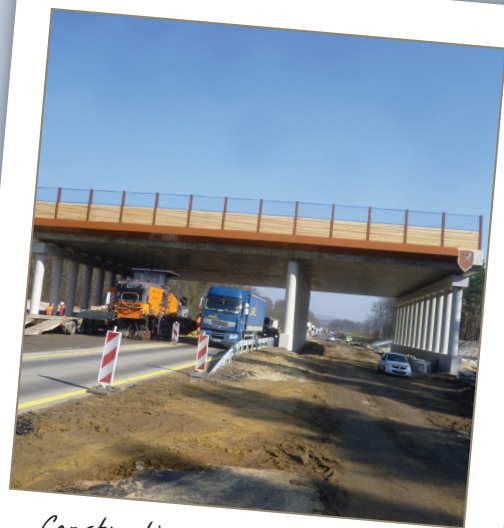
Construction du grand passage faune de Tillet sur la RN2
