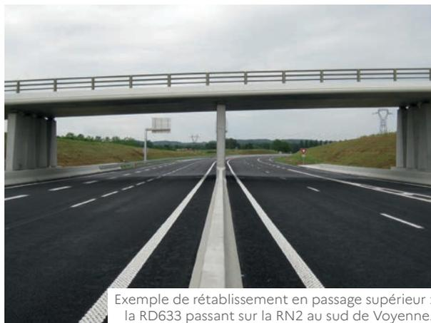
Exemple de rétablissement en passage supérieur : la RD633 passant sur la RN2 au sud de Voenne.
