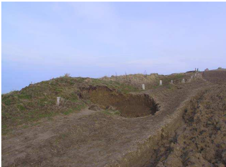
Photo n°2 : l'affaissement entre le cran poulet et le rouge trou.
