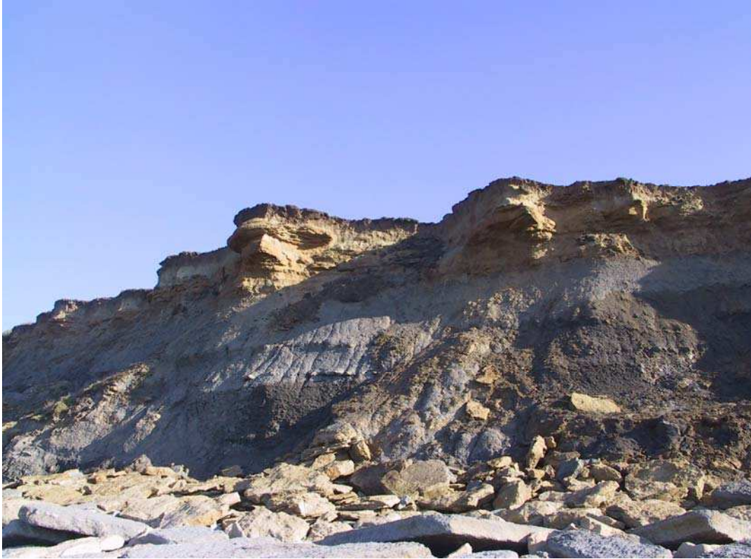
Photo n°8 : les corniches vues depuis l'estran
