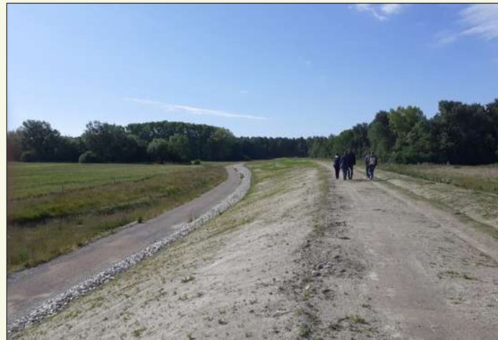
Digue rétro-littorale Bois de Sapins (Groffliers – 62)
