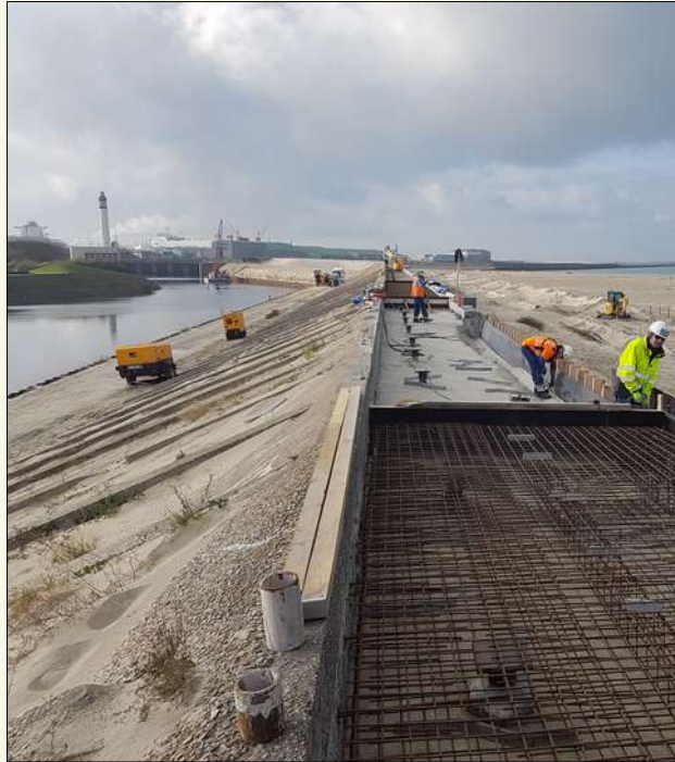
Digue bétonnée : digue des Alliés à Dunkerque Travaux 2018
