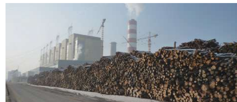
Centrale biomasse KOGEBAN à Nesle
