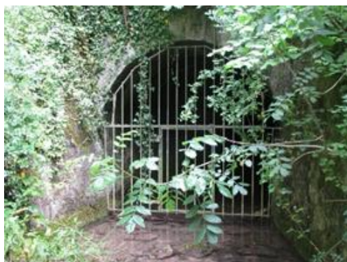
Tunnel hydraulique aménagé par la CMNF
