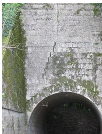
Ancien pont fissuré
