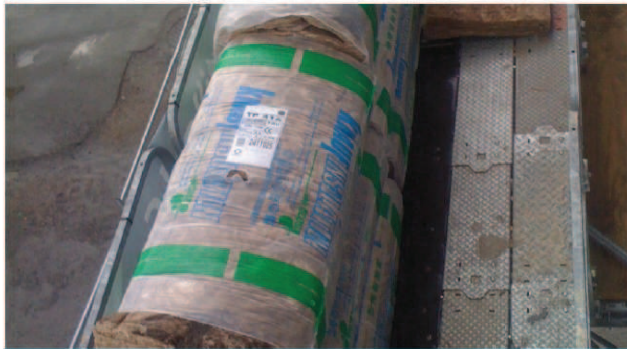
Mise en œuvre d'isolants humides
