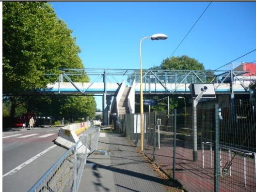
Photo 16 : Vue de la passerelle au dessus de la rue Baudouin IX
