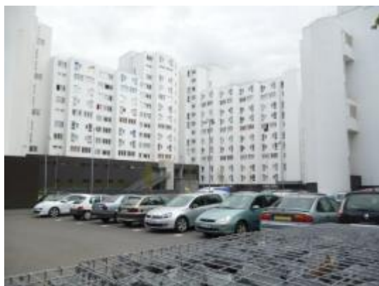
Photo 10 : Immeubles depuis la rue Baudouin IX
