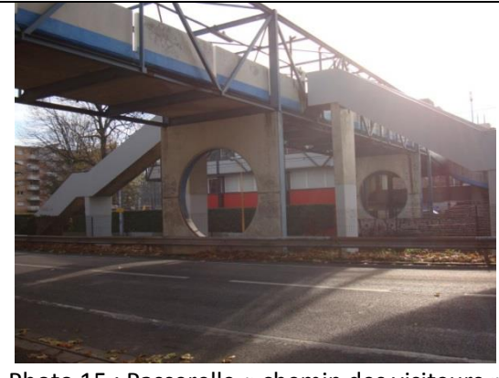
Photo 15 : Passerelle « chemin des visiteurs »
