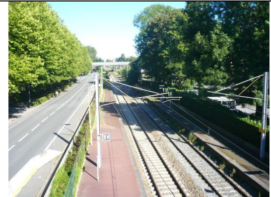
Photo 18 : Rue Baudouin IX et voie ferrée
