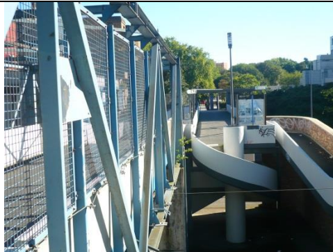
Photo 17 : Passerelle « chemin des visiteurs »
