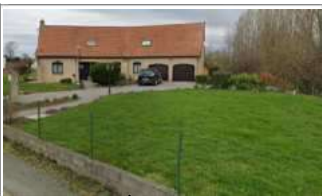
Annexe 6 photo des résidences individuelles dans un rayon de 100m
