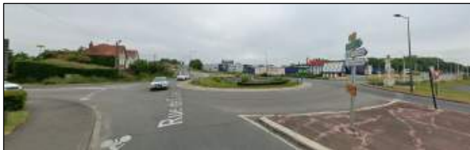
Figure 79 : Giratoire proche du projet D943 – Source : Googlestreetview 2023
