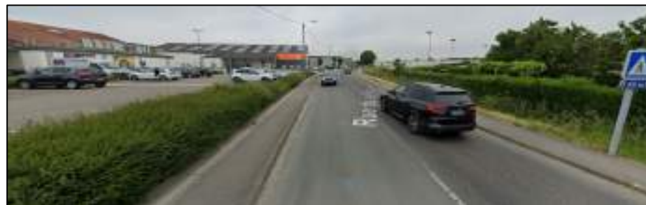
Figure 74 : Trottoir le long de la rue de la Rocade – Source : GoogleStreetView2023
