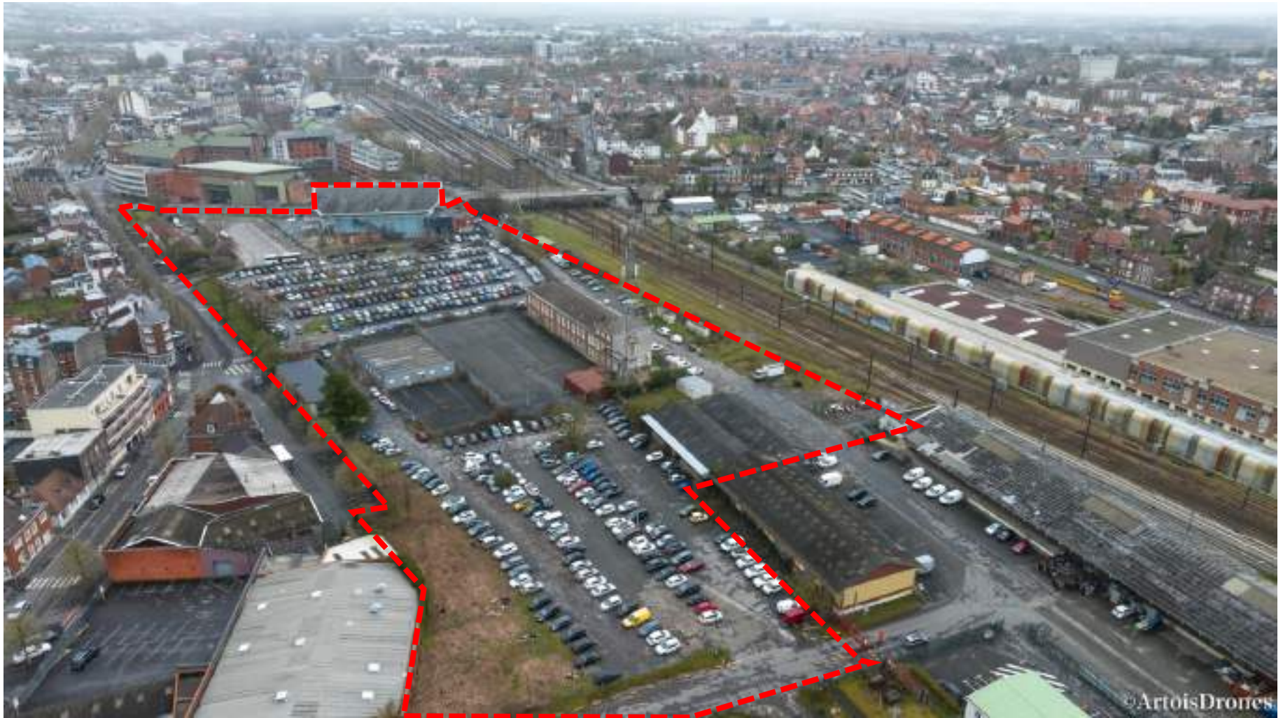
V1 : Vue générale du site – mars 2023
