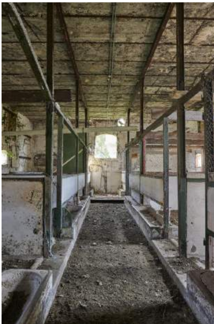
Vue intérieure d'une des porcheries.
