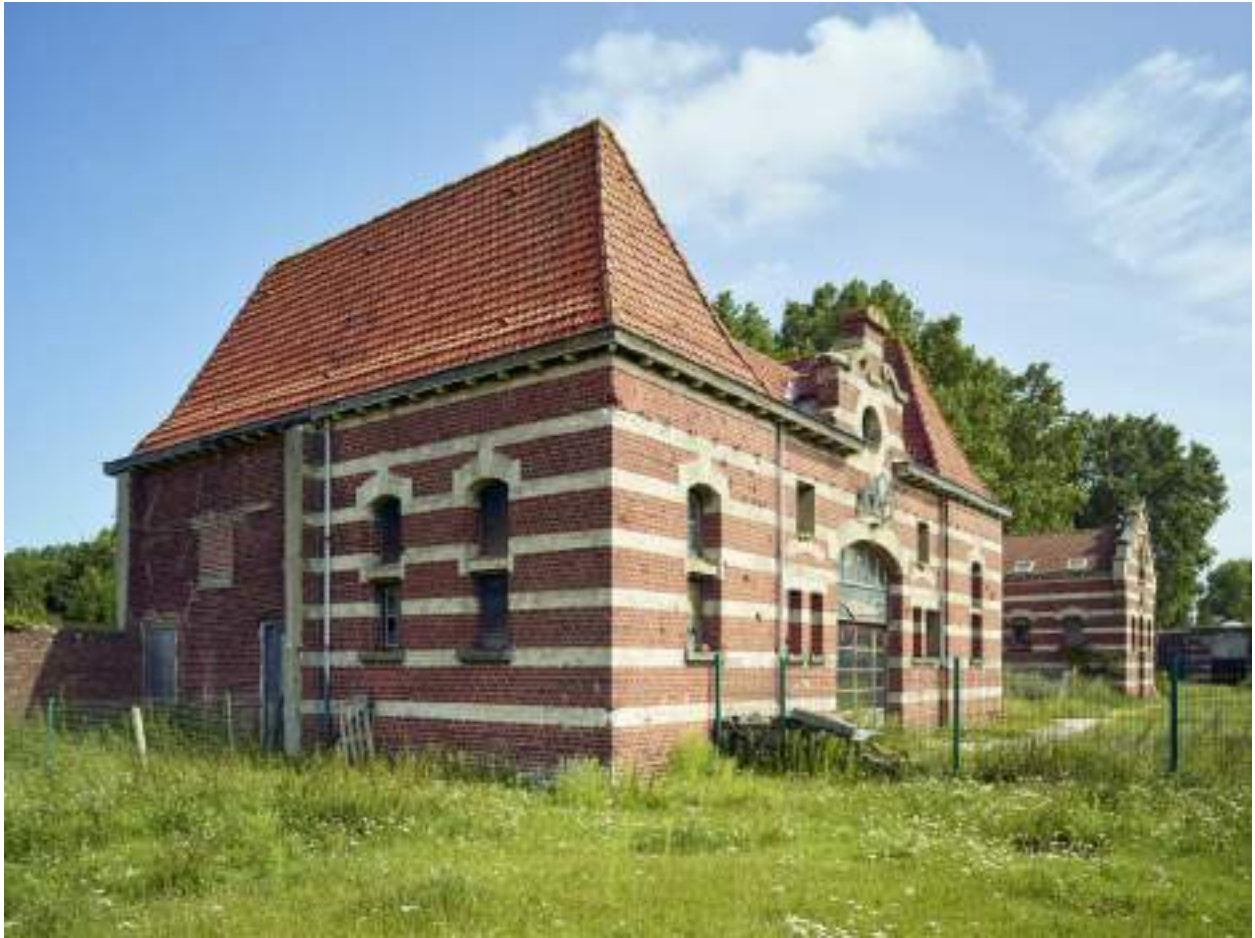
Laiterie et magasin, vue de trois-quarts sud-ouest.
