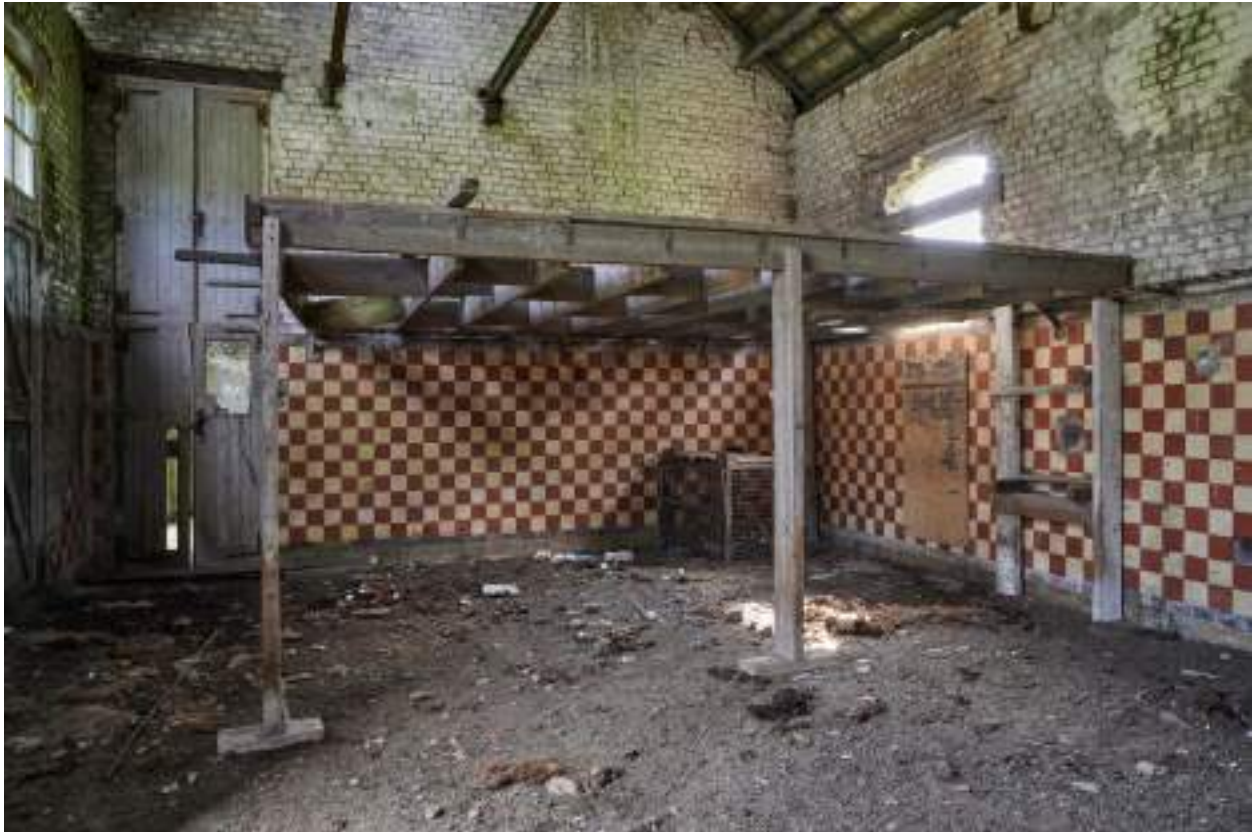
Vue générale intérieure de l'abattoir.
