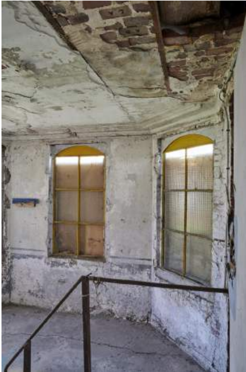
Vue intérieure de l'office du logement du chef d'élevage.
