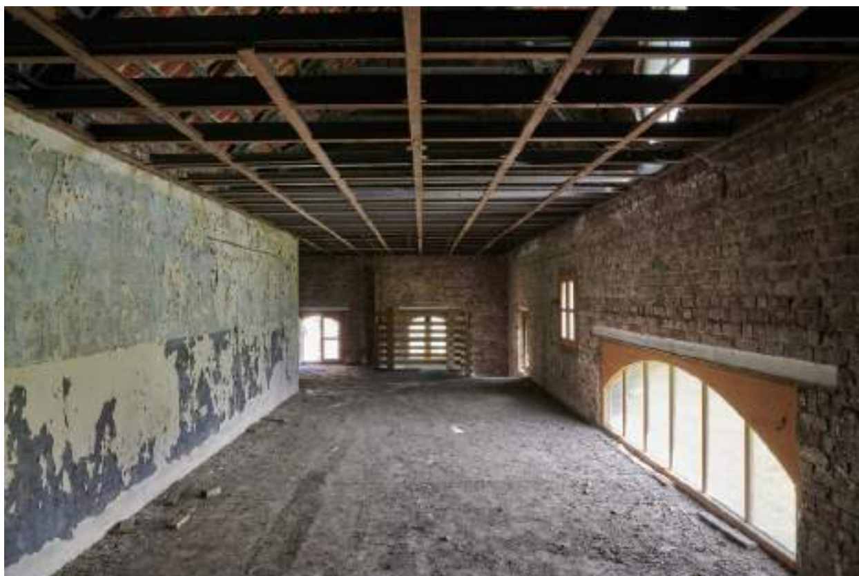
Combles des anciens magasins.
