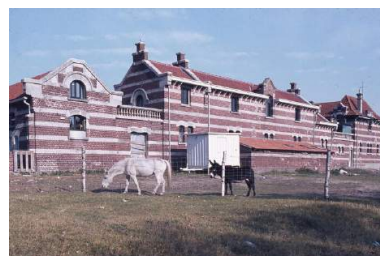
Bâtiments fermant la cour au sud, élévation extérieure en 1980. Phot. Eric Dessert IVR31_19805901389ZA
