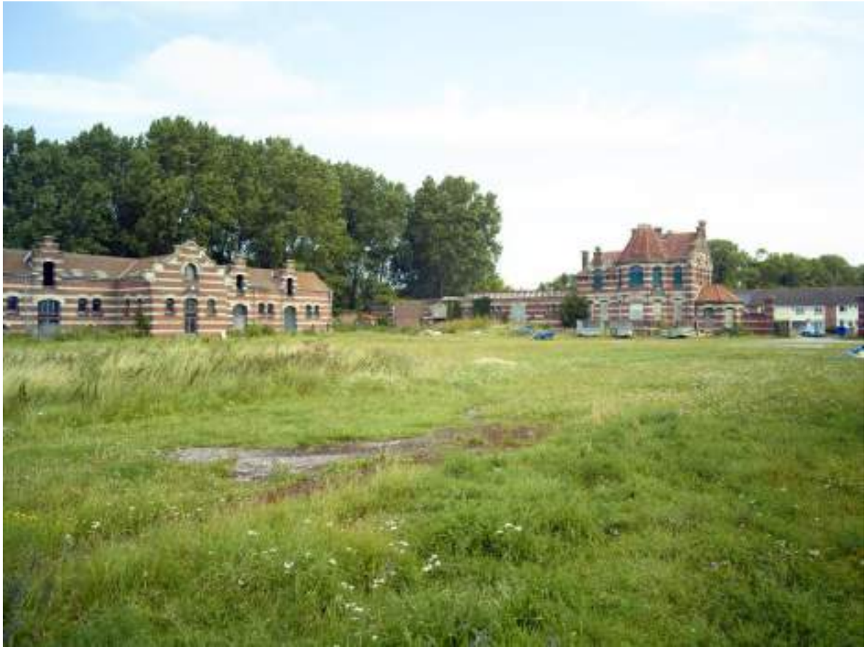
Vue d'ensemble nord-est des bâtiments de la ferme.
