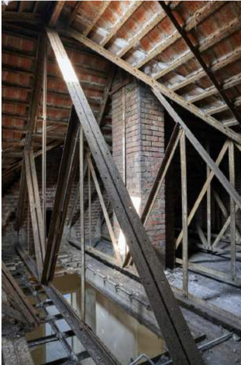
Ferme métallique du logement du chef d'élevage.
