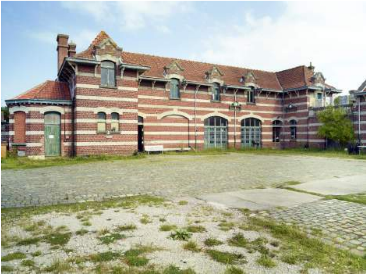
Façade sur cour des anciennes étables et de la remise à matériel.
