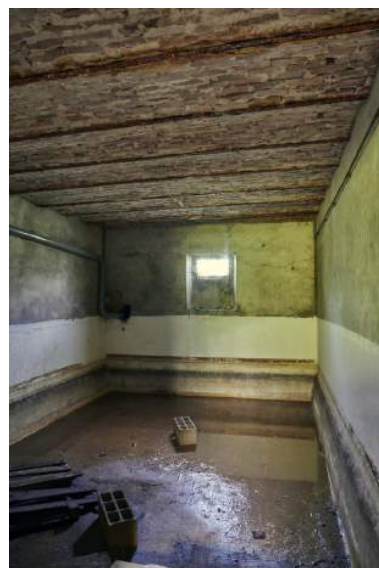
Sous-sol du logement du chef d'élevage. Phot. Pierre Thibaut IVR32_20215900197NUCA
