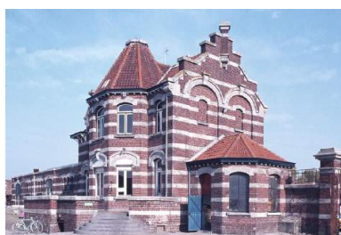
L'habitation du chef d'élevage en 1980, vue d'ensemble sur cour. Phot. Eric Dessert IVR31_19805901407ZA
