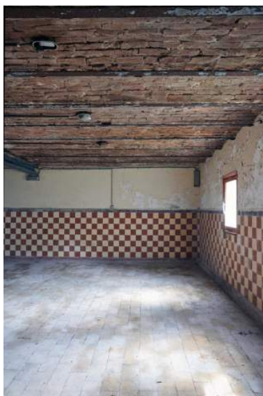
Sous-sol du logement du chef d'élevage. Phot. Pierre Thibaut IVR32_20215900196NUCA
