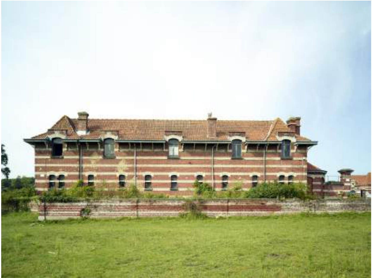
Vue d'ensemble sud des anciennes étables de la ferme et de la remise à matériel.
