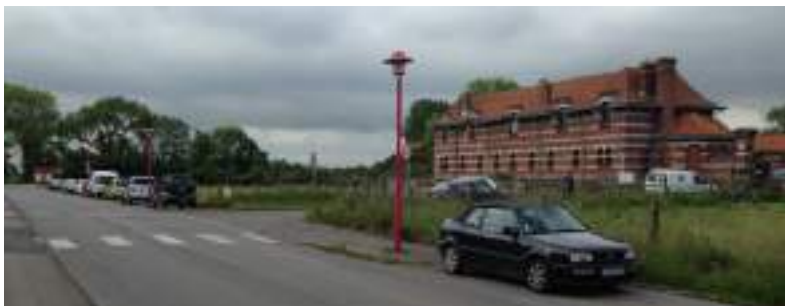
Ferme Nord (façade)
