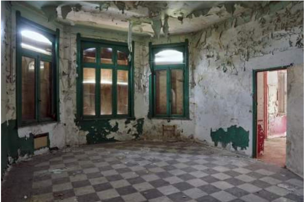
Vue intérieurs d'une des chambres du rez-de-chaussée du logement du chef d'élevage.
