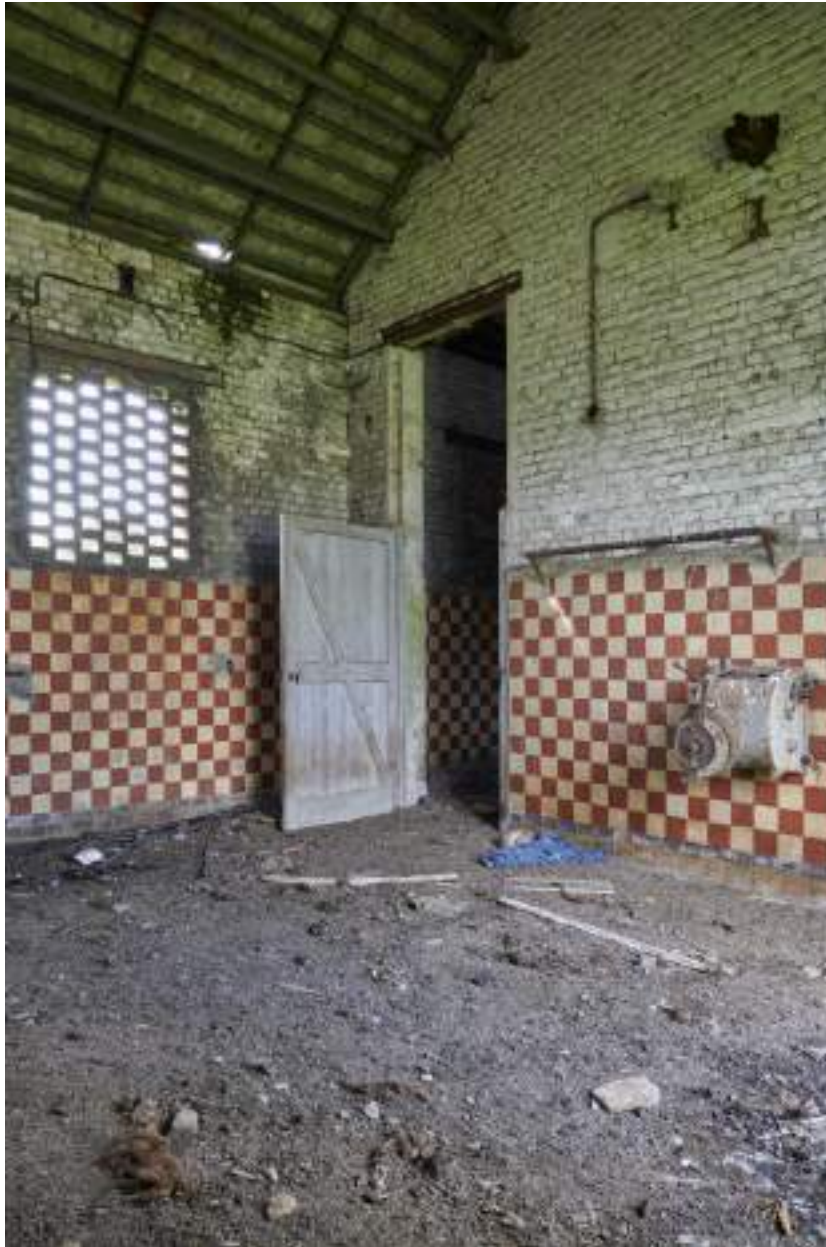
Porte d'entrée de la salle d'abattage.
