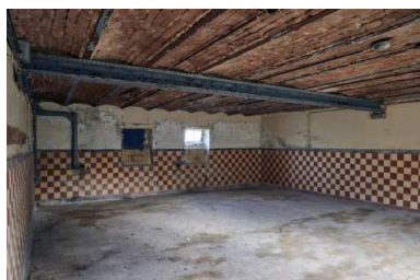
Sous-sol du logement du chef d'élevage. Phot. Pierre Thibaut IVR32_20215900195NUCA
