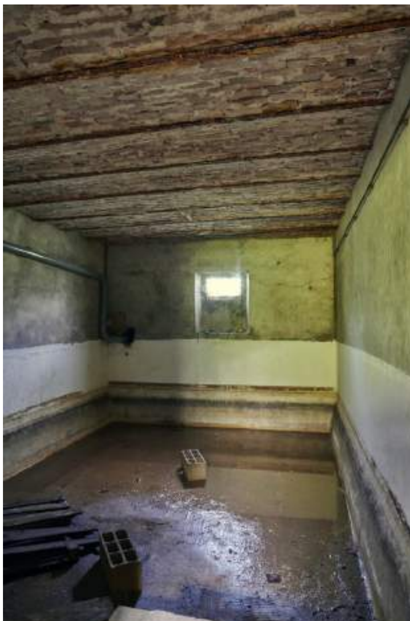
Sous-sol du logement du chef d'élevage.
