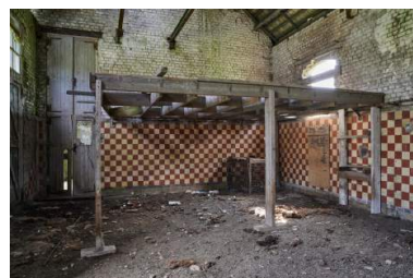
Vue générale intérieure de l'abattoir. Phot. Pierre Thibaut IVR32_20215900202NUCA
