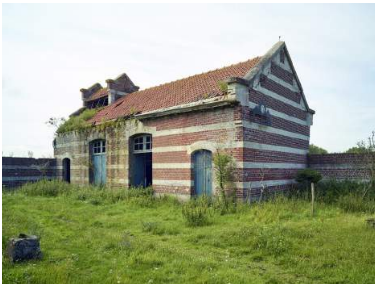
Abattoir, vue d'ensemble nord-est.
