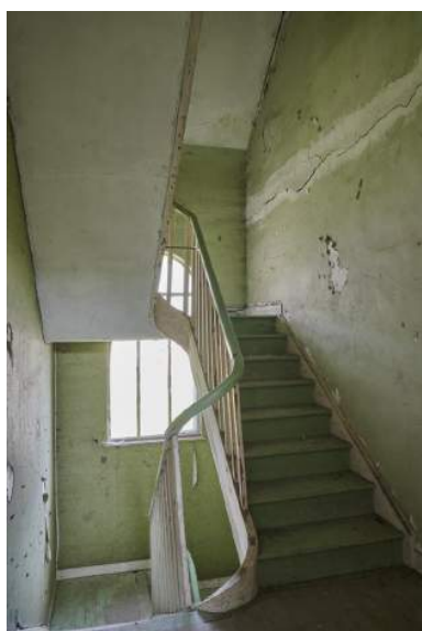
Escalier rampe sur rampe du logement du chef d'élevage. Phot. Pierre Thibaut IVR32_20215900189NUCA
