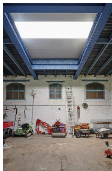
Vue d'ensemble intérieur de l'ancien magasin. Phot. Pierre Thibaut IVR32_20215900187NUCA
