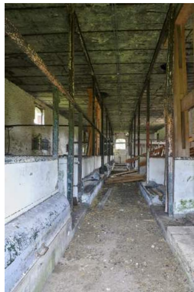
Vue d'intérieure d'une des porcheries avec ses enclos répartis de part et d'autre de l'allée centrale. Phot. Pierre Thibaut IVR32_20215900198NUCA
