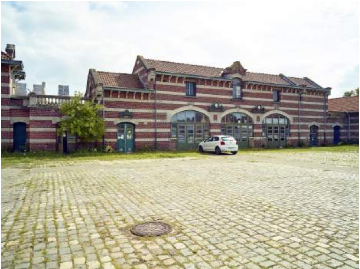
Facçade sur cour de la remise à matériel agricole.
