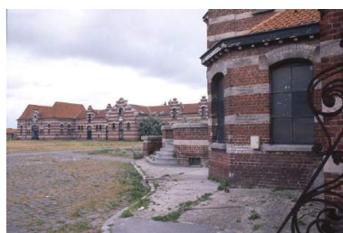
Vue d'ensemble sur cour des étables, vue générale depuis l'habitation du chef d'élevage en 1990. Phot. Philippe Dapvril IVR31_19905900626ZA
