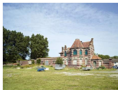
Vue d'ensemble du logement du chef d'élevage, depuis l'ouest. Phot. Pierre Thibaut IVR32_20215900224NUCA
