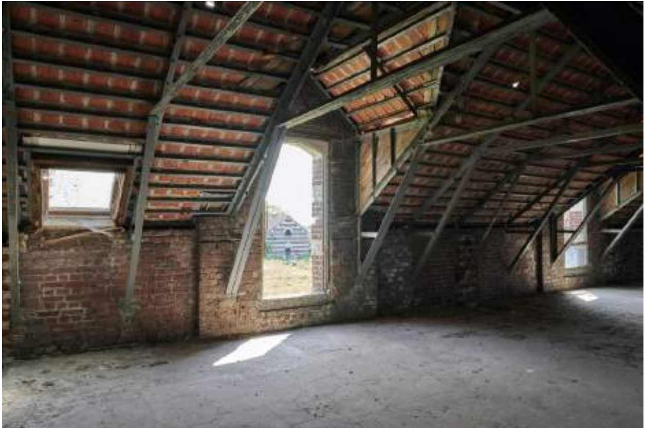
Vue intérieure d'une lucarne des anciennes grandes étables.
