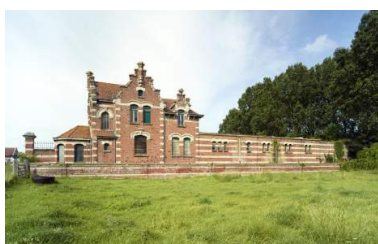
Logement du chef d'élevage ; vue d'ensemble depuis l'est. Phot. Pierre Thibaut IVR32_20215900228NUCA
