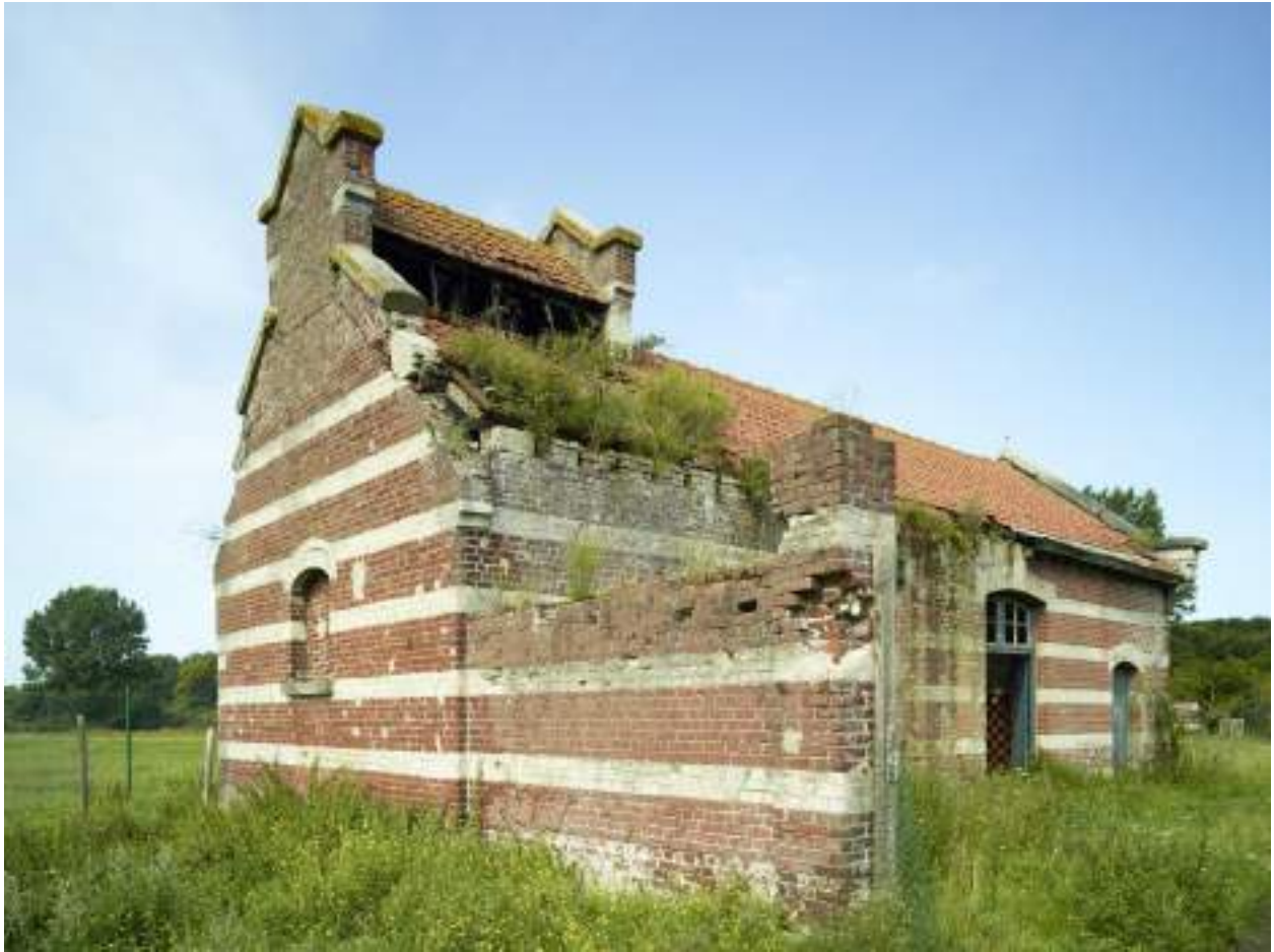
Abattoir, vue d'ensemble sud-est.
