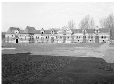
Façade sur cour des étables et d'un corps de bâtiment servant de magasin en 2003. Phot. Philippe Dapvril IVR31_20035900239V
