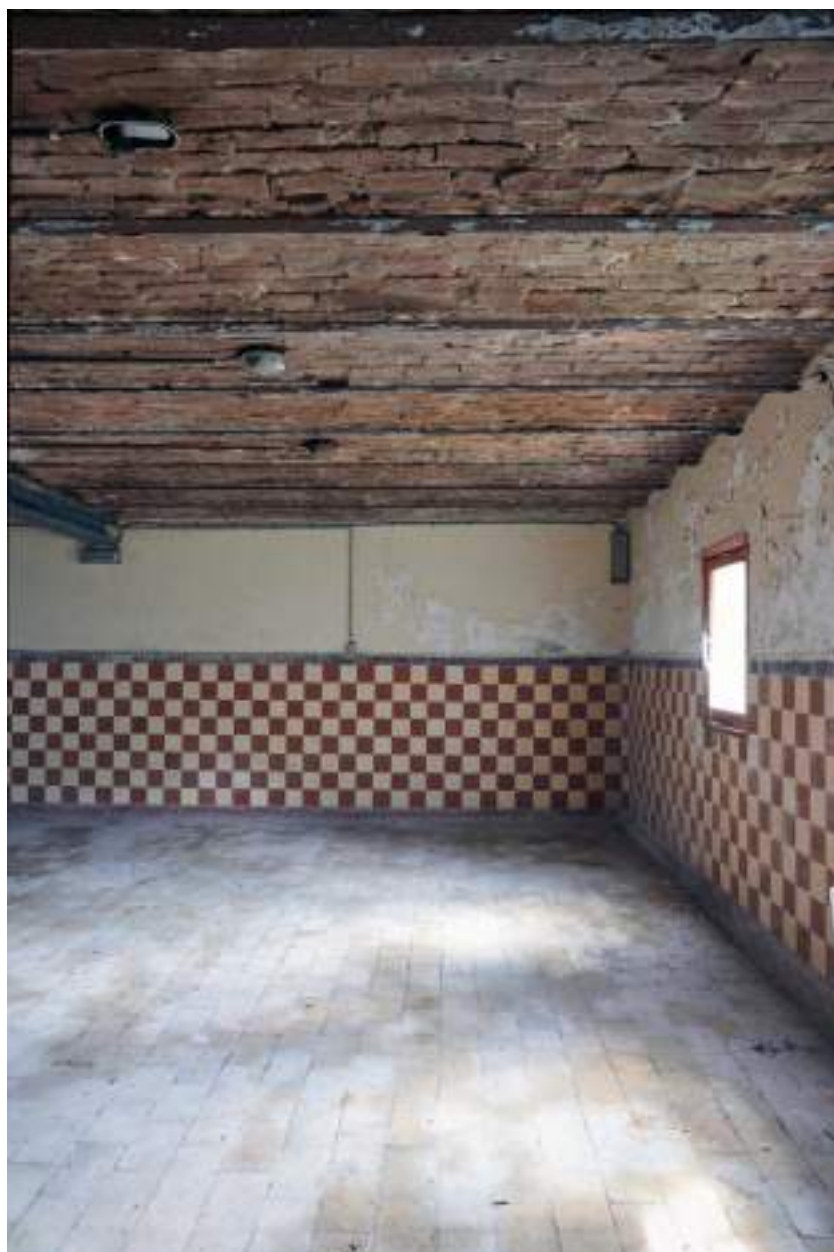
Sous-sol du logement du chef d'élevage.
