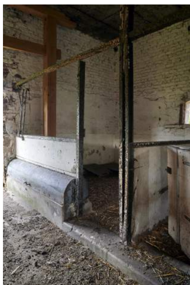
Détail d'un enclos de porcherie et de sa mangeoire. Phot. Pierre Thibaut IVR32_20215900199NUCA
