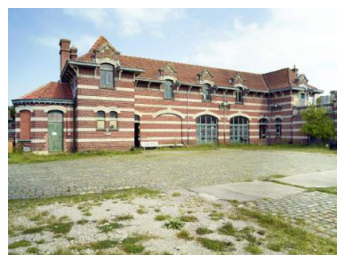
Façade sur cour des anciennes étables et de la remise à matériel. Phot. Pierre Thibaut IVR32_20215900226NUCA
