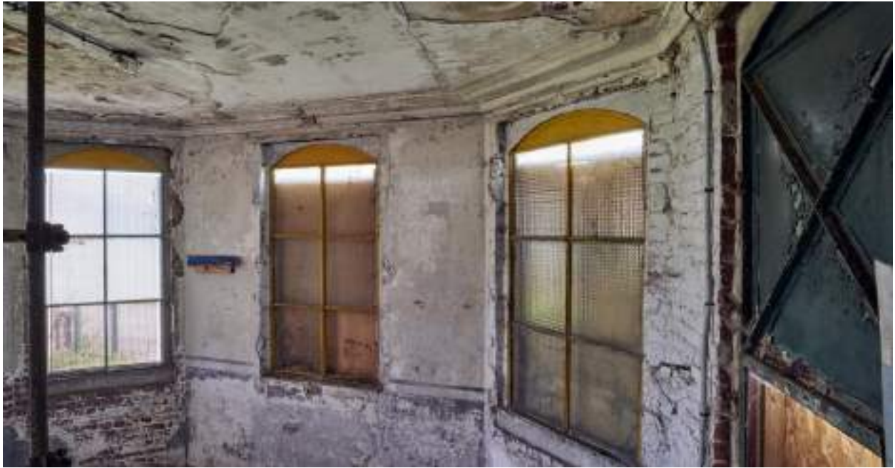
Vue intérieure de l'office du logement du chef d'élevage.
