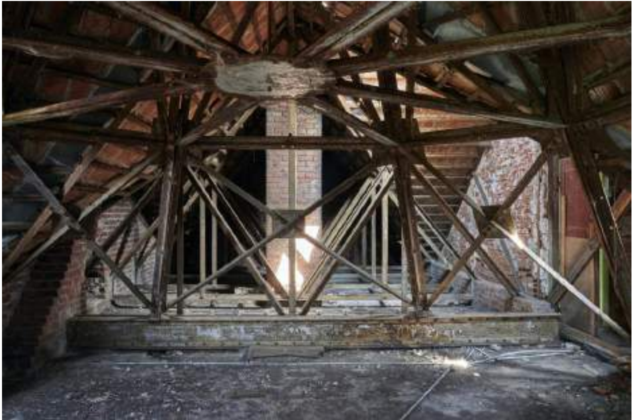
Charpente métalliques sous combles du logement du chef d'élevage.
