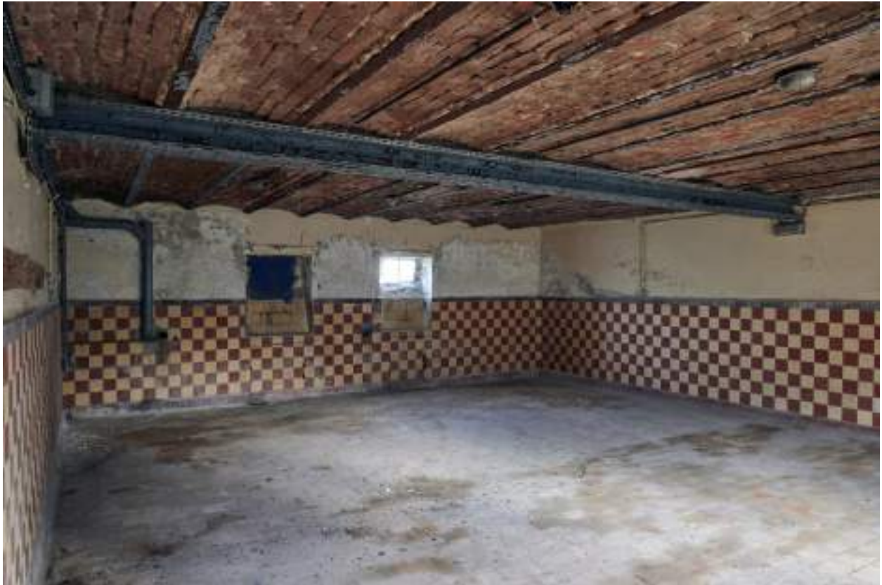
Sous-sol du logement du chef d'élevage.
