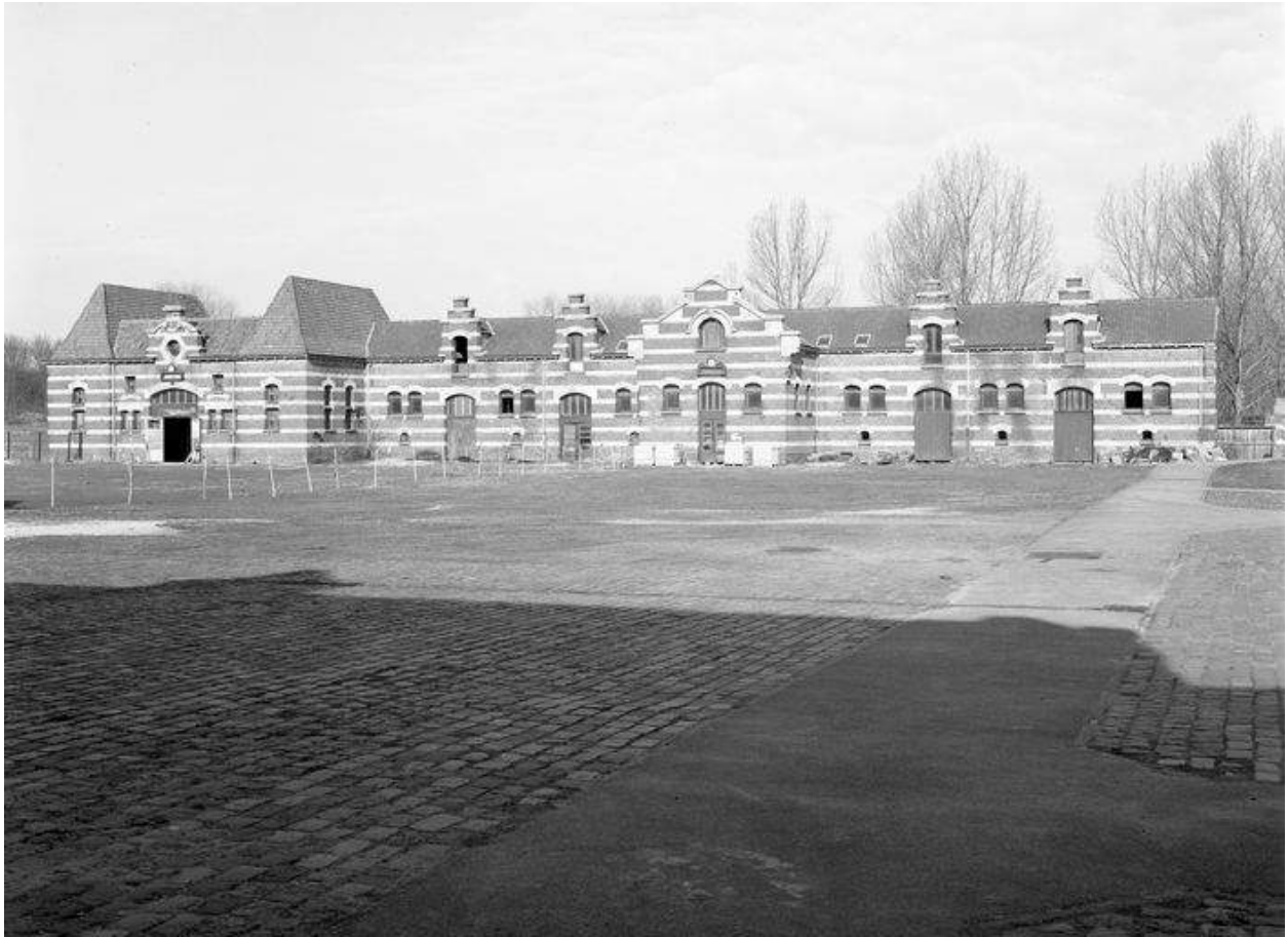
Façade sur cour des étables et d'un corps de bâtiment servant de magasin en 2003.
