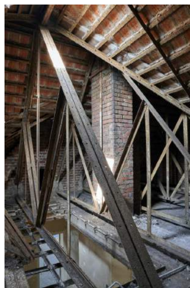
Ferme métallique du logement du chef d'élevage. Phot. Pierre Thibaut IVR32_20215900192NUCA
