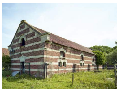
Vue d'une des anciennes porcheries, vue de trois quarts.
