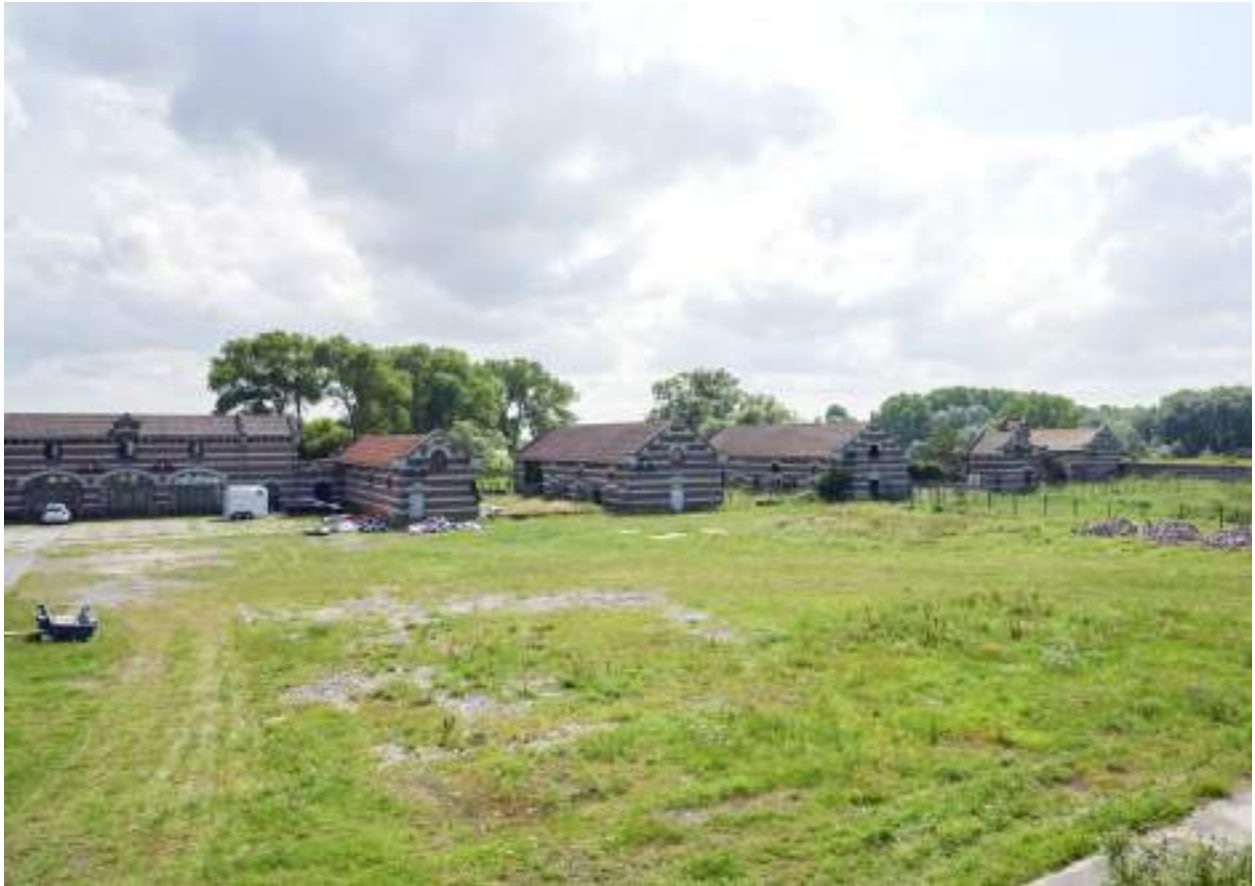
Vue d'ensemble des bâtiments de bergerie et porcherie depuis le nord.
