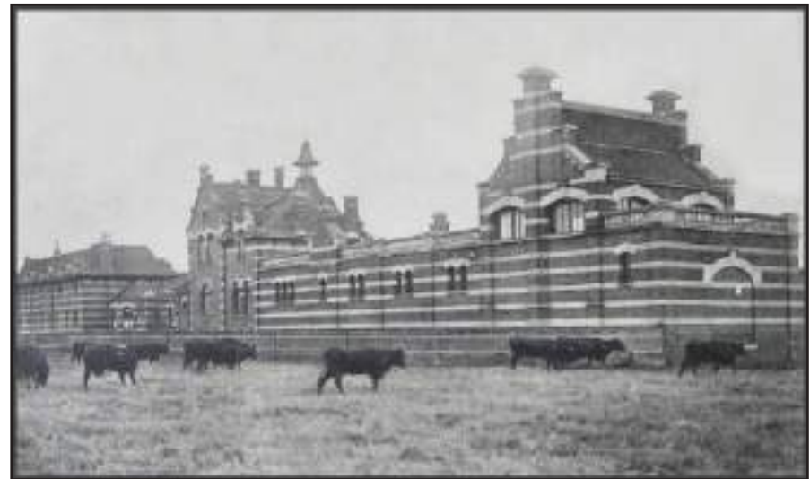
L'angle Nord-Est de la Ferme Nord «intact» avec son bâtiment d'angle aujourd'hui démolì.
