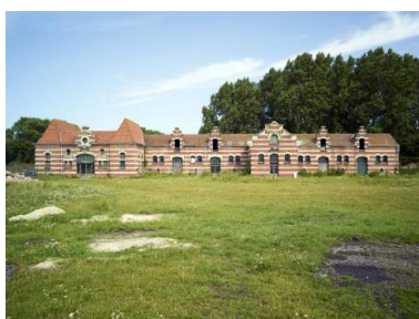
Vue générale sur cour des étables et du magasin. Phot. Pierre Thibaut IVR32_20215900209NUCA
