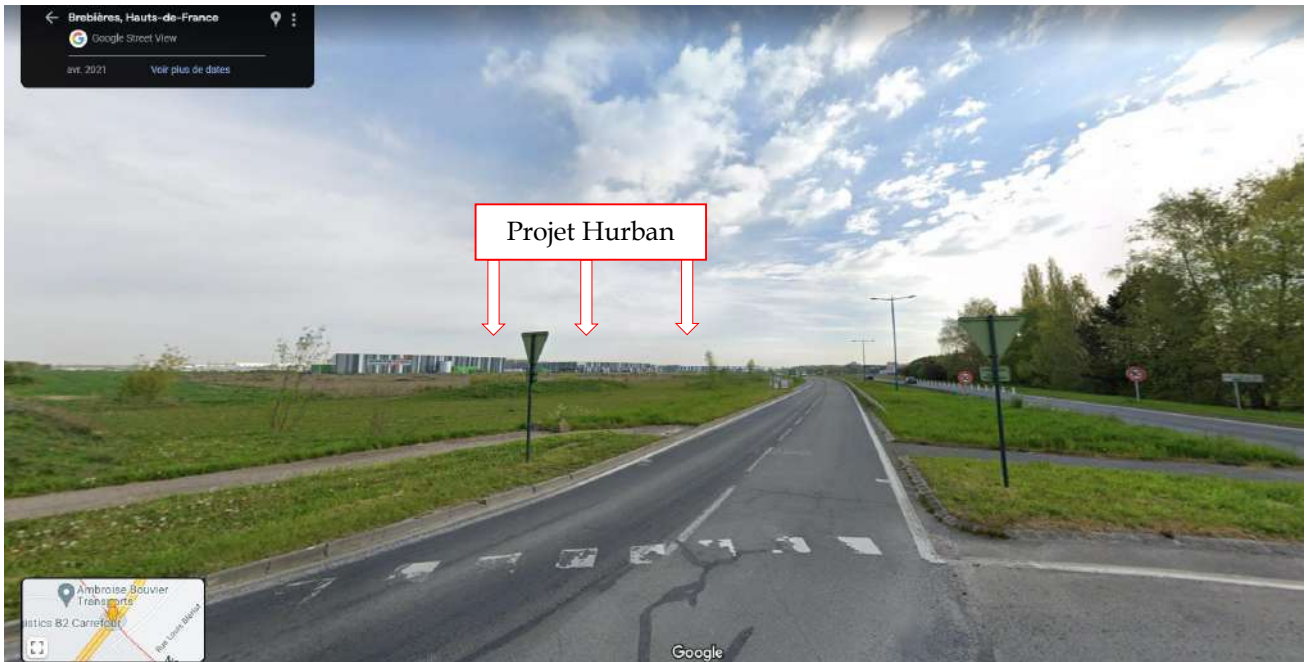
Photographie n°2 (vue éloignée) - Avril 2021
