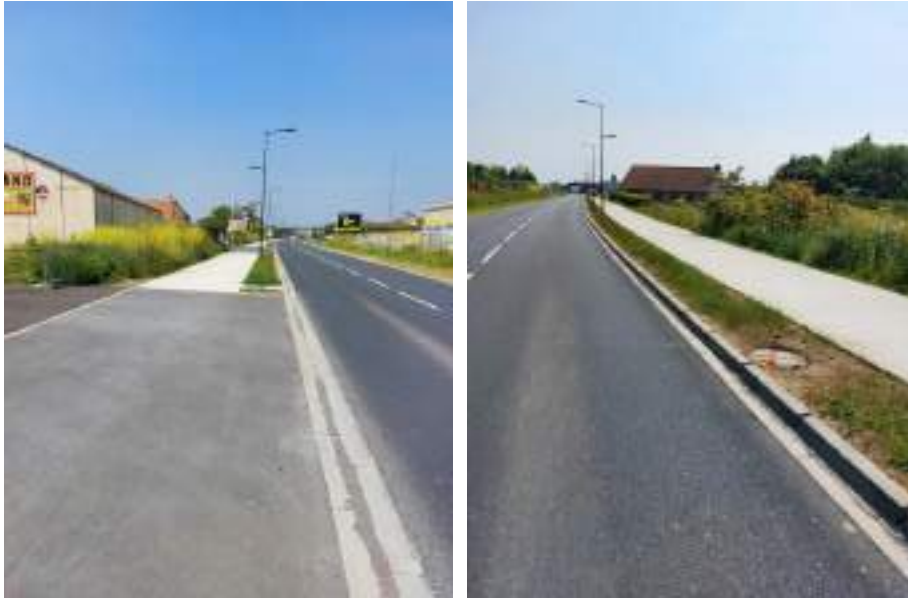
Figure 51 : Prise de vue de la RD17 – Source : Urbycom 2023
