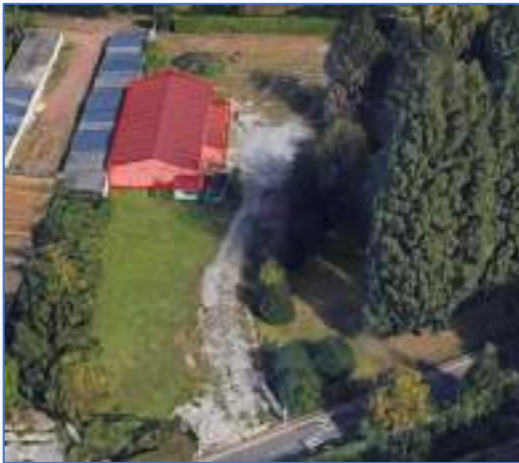
Vue 3D de la construction présente sur la parcelle BS n°421
