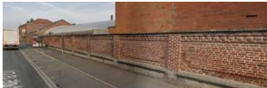
Figure 58 : Patrimoine industriel – Source : googlestreetview août 2022
