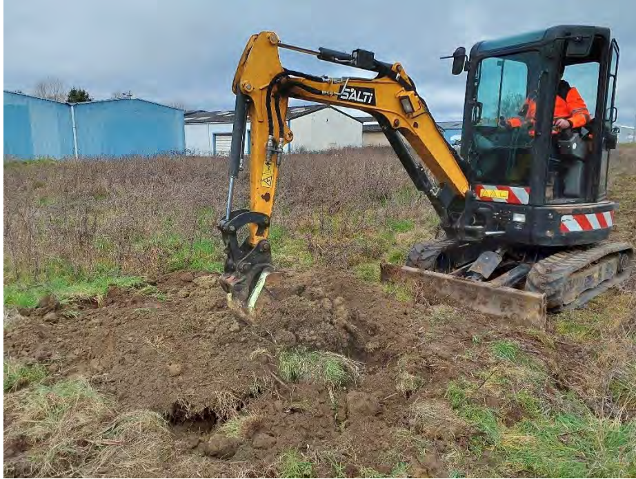
REALISATION D'UN SONDAGE AVEC LA PELLE MECANIQUE
