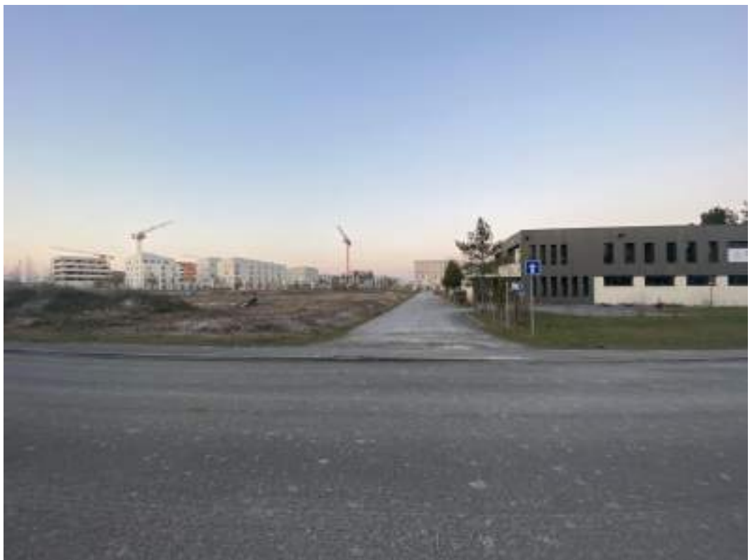
Figure 1 : Prises de vue des alentours du site ; Linkcity
