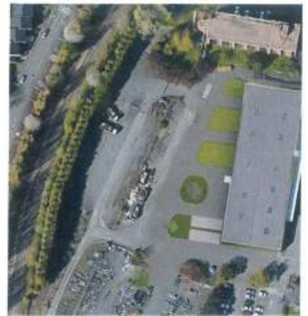
Vue aérienne de l'existant
