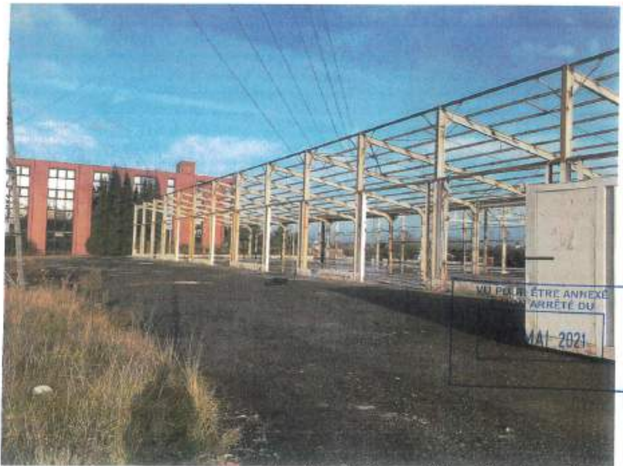
Vue arrière du bâtiment après dépose de l'enveloppe extérieure.
