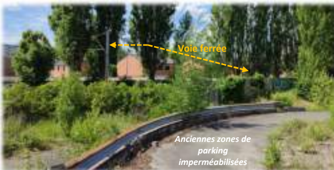
15- Vue de la zone de projet sur sa limite Ouest et la voie ferrée existante
