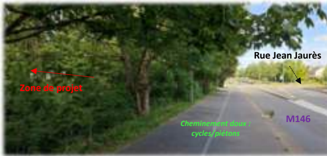
12- Vue sur le carrefour Boulevard de Lezennes # Rue Jean Jaurès direction Villeneuve d'Ascq
