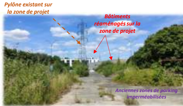
2- Vue depuis le Sud de la zone de projet vers les bâtiments réaménagés MCI et bâtiment de bureaux
