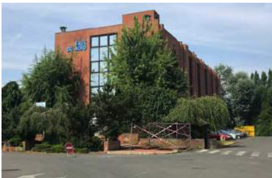
Bâtiment existant avant réhabilitation
