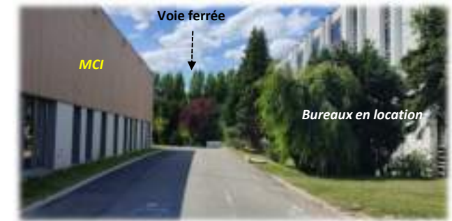
14- Vue entre les deux bâtiments déjà réaménagés
