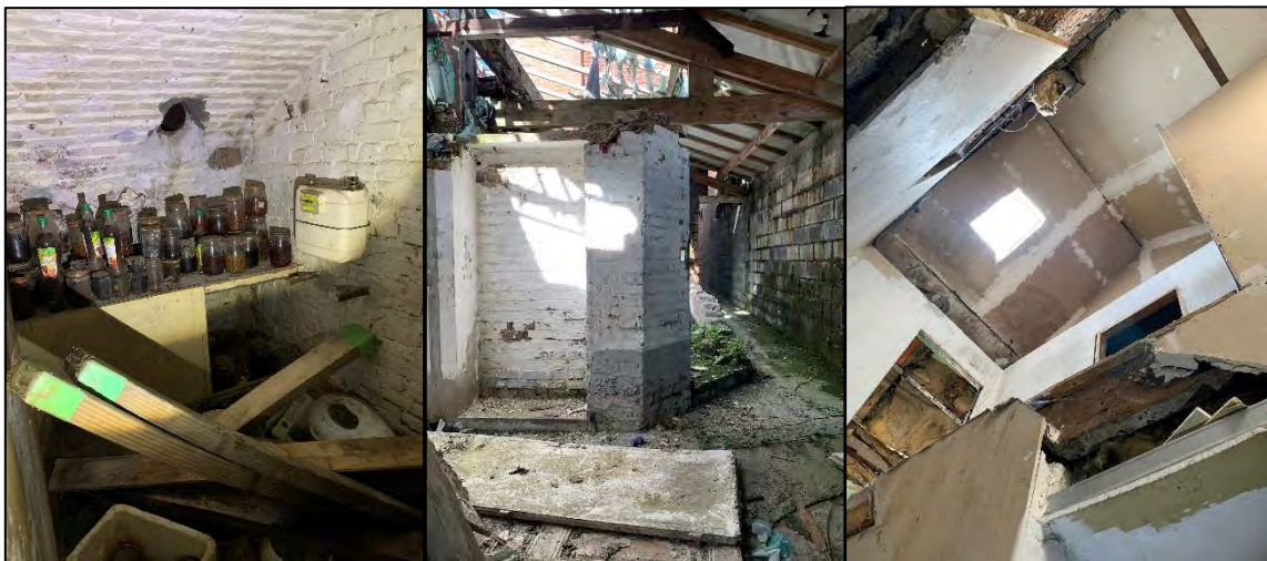
Cave, garage et dernier étage de l'habitation parcelle 249
