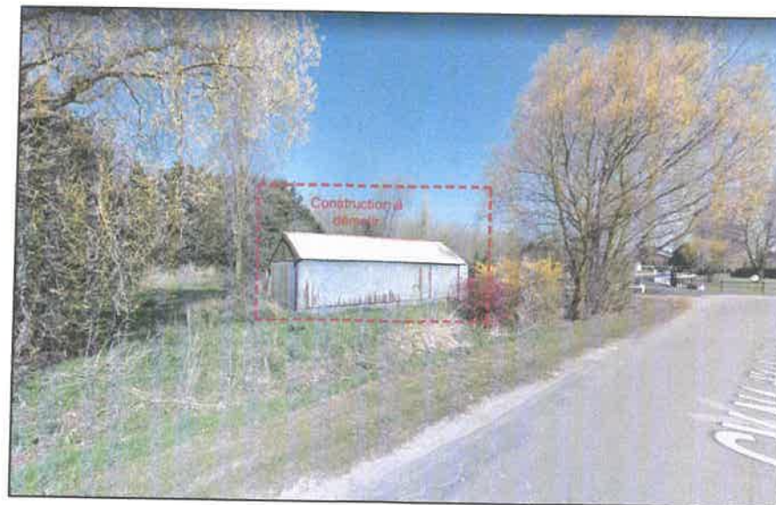
D _ PHOTOGRAPHIE ENVIRONNEMENT LOINTAIN _ VUE DU BATIMENT A DEMOLIR POUR LE SITE DES TROIS GITES
