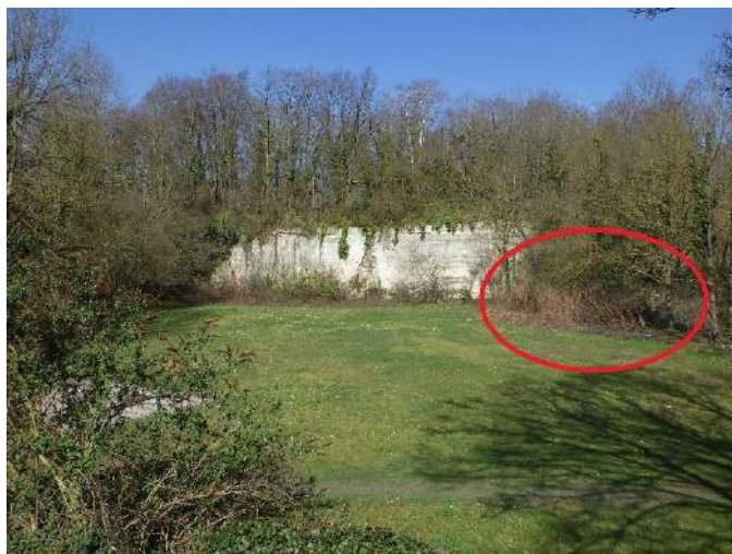
Station de Reynoutria japonica sur la zone d'étude
