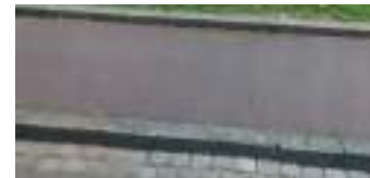
Trottoir enrobé, bordure et caniveau granit
