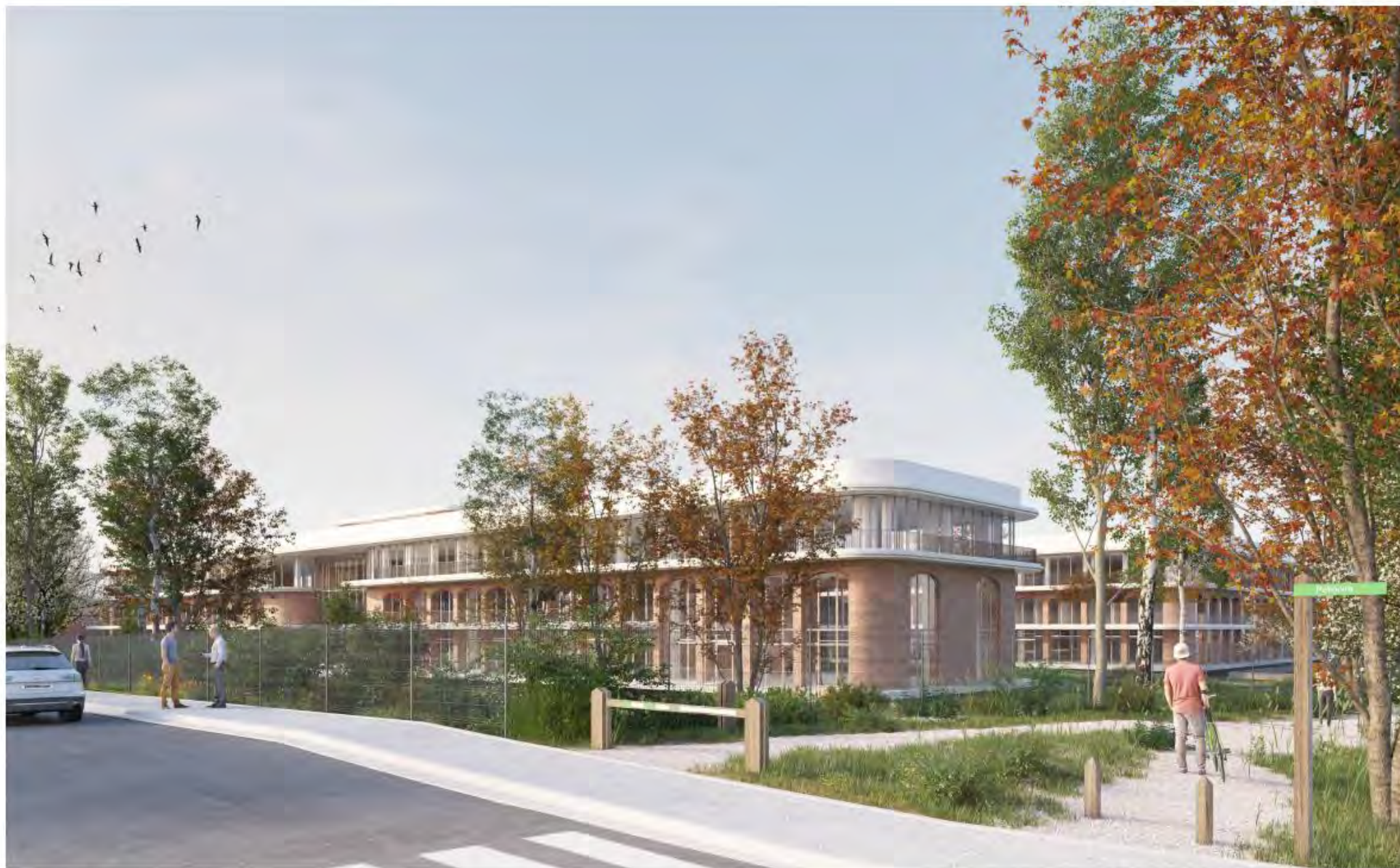
VUE DEPUIS LE PONT DU CANAL DE ROUBAIX
