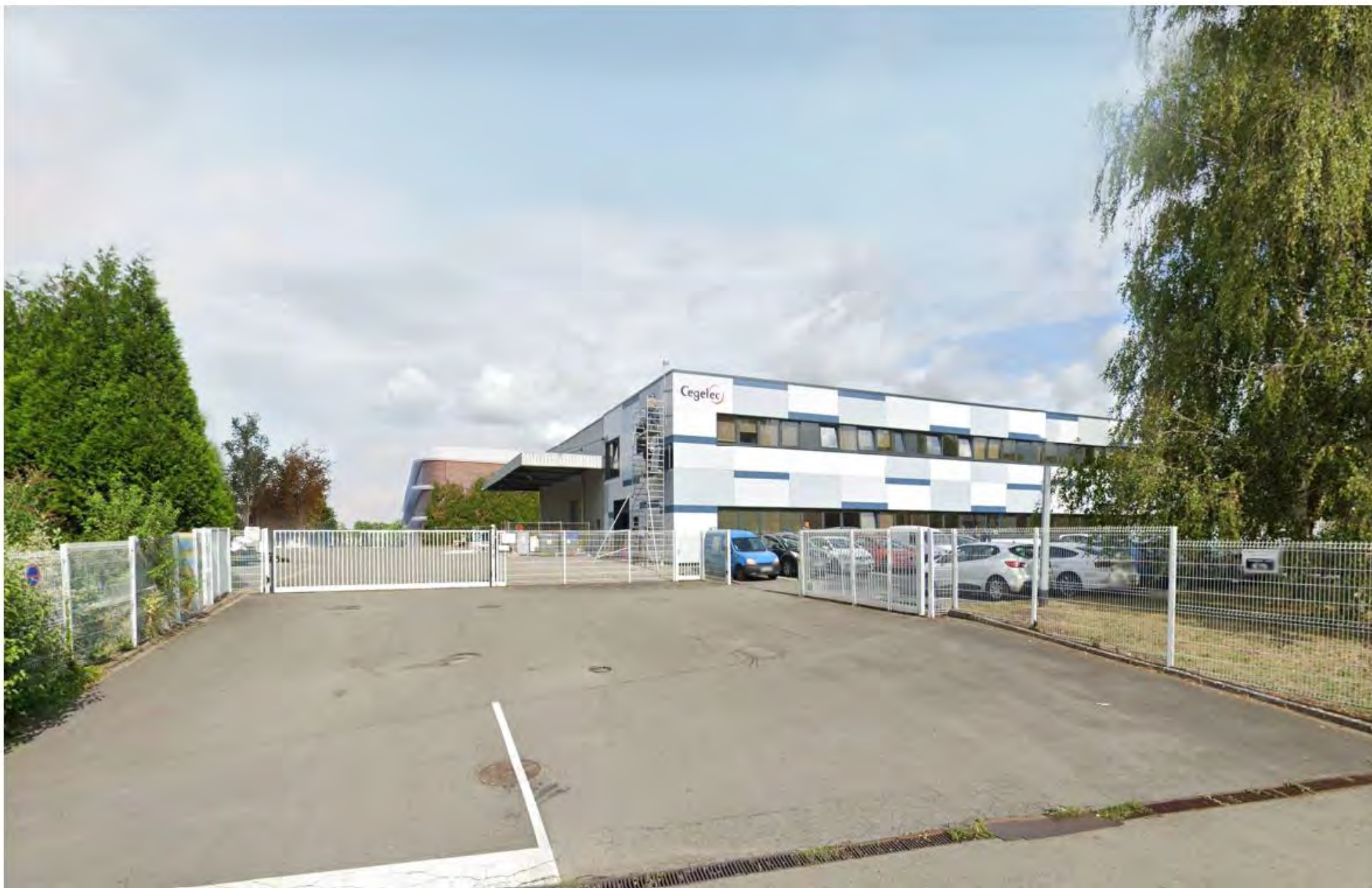
VUE ENTREE DU SITE DEPUIS ENTREE RUE PASTEUR
