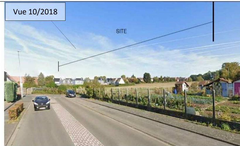
Photographie 01 - depuis l'avenue du Ferrain
