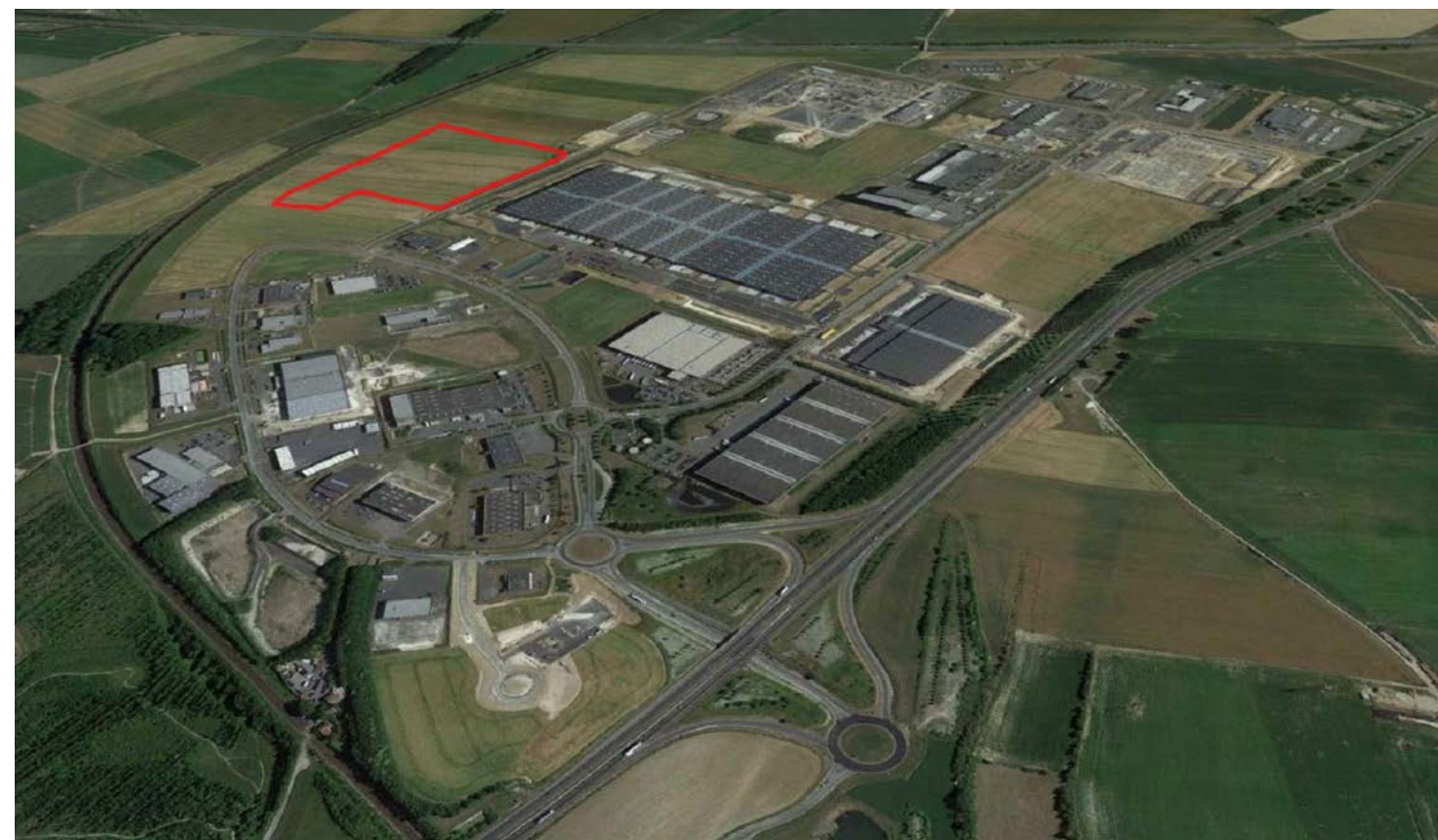
P1 - Photo aérienne de la ZA ACTIPARC 07/2019
