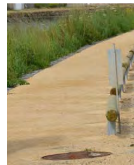
Grave-calcaire ou sable stabilisé pour le piétonnier
