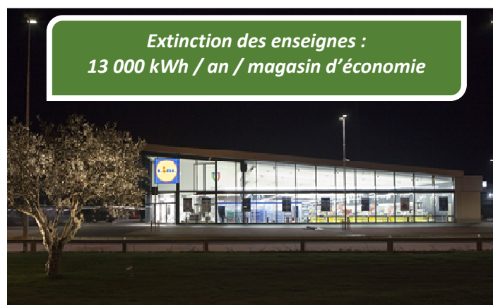
Un magasin éclairé jusqu'à sa fermeture au public totalement éteint après le départ du personnel
