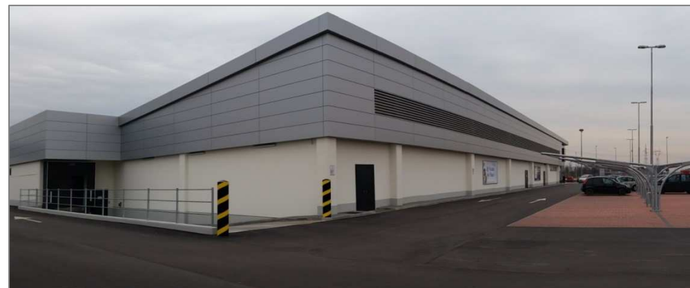
Bardage métallique alucobond recyclable à 100%
