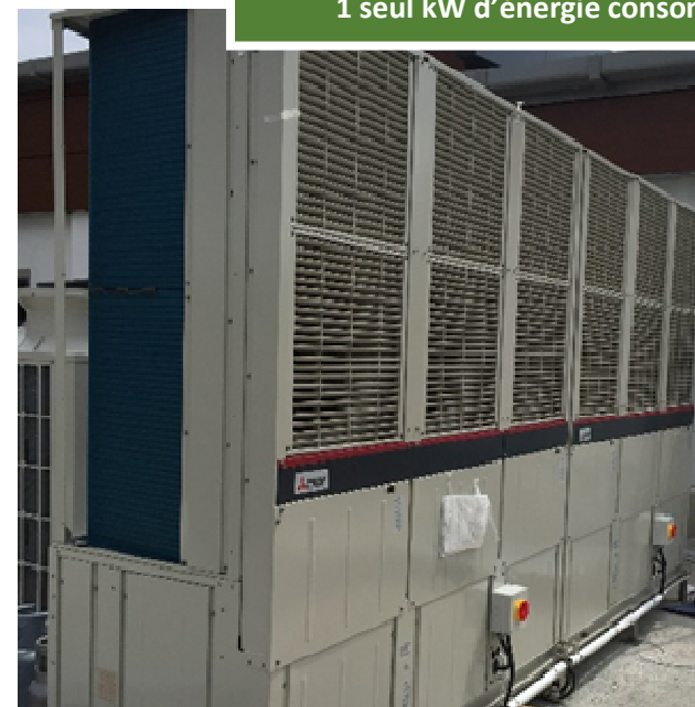
Compresseurs pour la production de chauffage/climatisation
