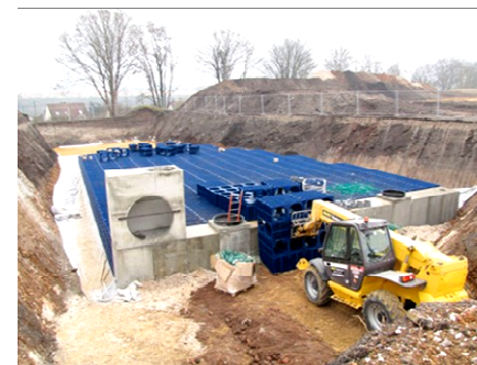
Construction d'un bassin de rétention enterré
