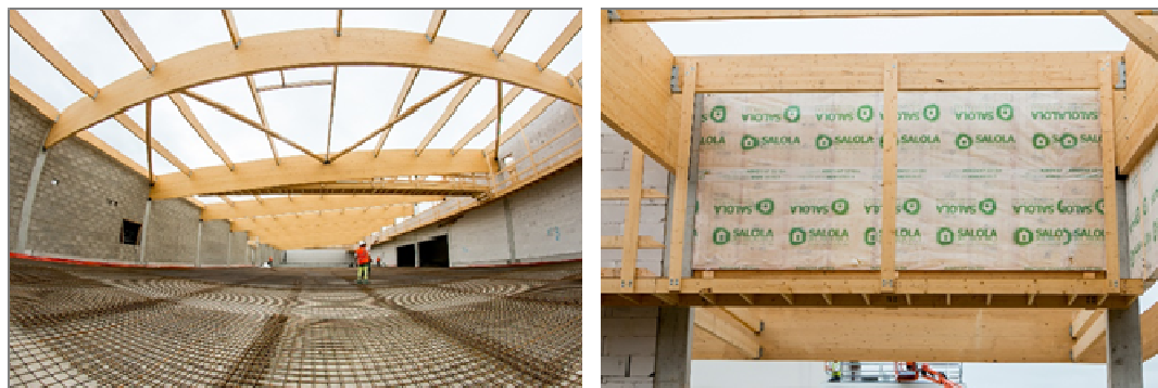
Charpente bois avec mise en œuvre d'un isolant respectueux de l'environnement
