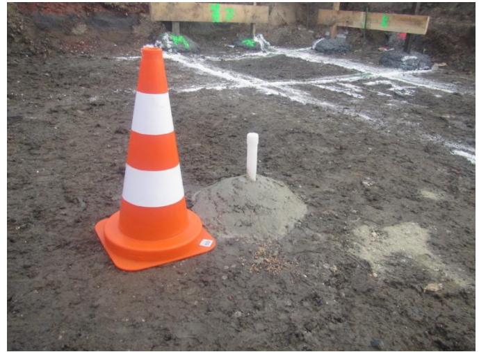
Figure 15 : Implantation du piézair et prélèvements des gaz de sol
