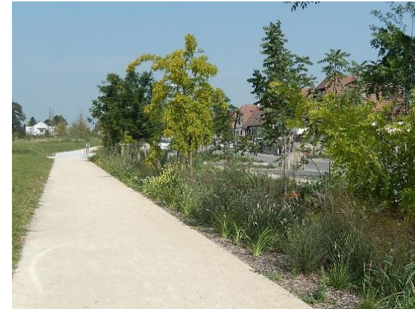
Exemple de trottoir en sable stabilisé non borduré avec noue plantée – Kingersheim – projet Empreinte-Osmose
