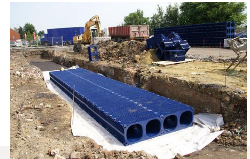
Cuve de récupération des Eaux sous chaussée
