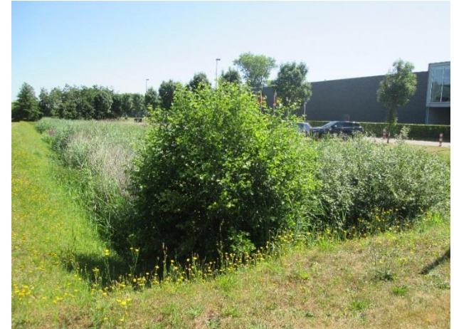
Bassin de récupération des Eaux de Pluies – Parc d'Activités d'Esserstraat LIEIDAL - Belgique
