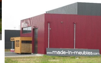
PA de la Planque à Pont-à-Marcq
