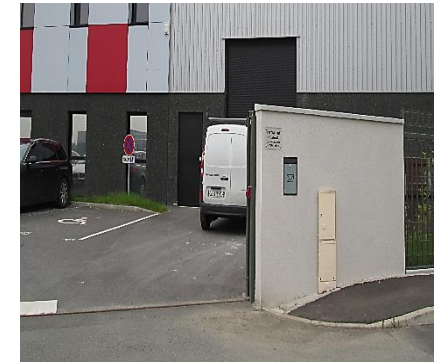
Murets techniques au PA de la Planque - Pont-à-Marque
