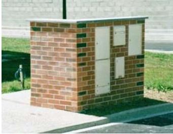
Muret technique en briques
