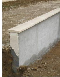
Muret technique en béton enduit gris
