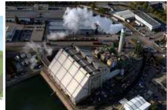
Réseau de chaleur avec UIOM
