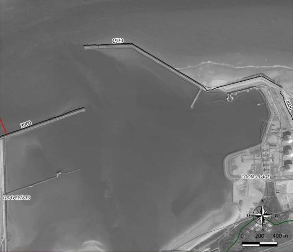
Jetée des Huttes à la jetée de Malo (Dunkerque) - Section 1
