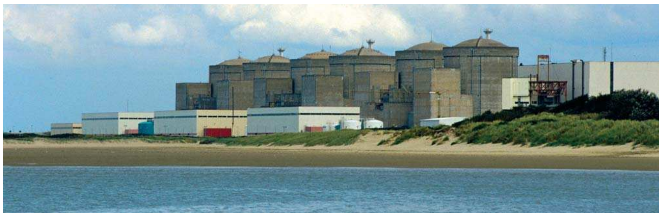
La centrale nucléaire de Gravelines.
