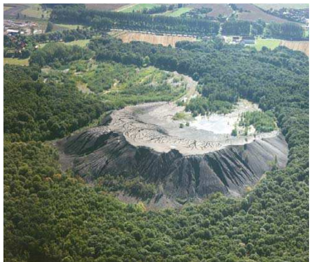
Le terril de Bruay-Labuissière avant réhabilitation (1994).
