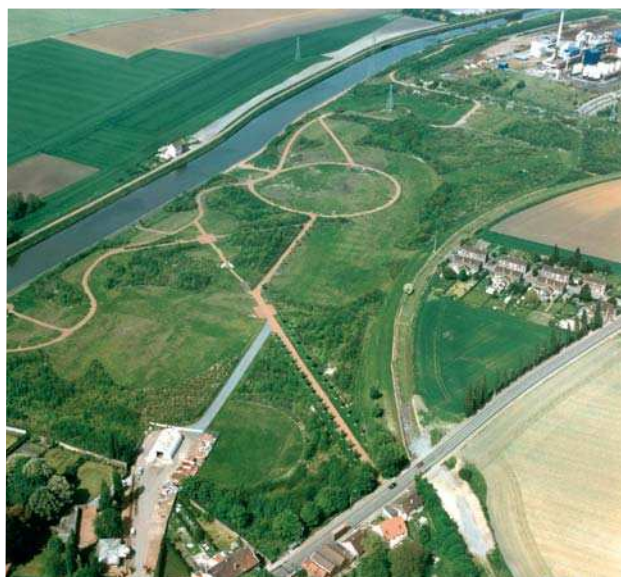
Courrières et Harnes : site des centrales électriques après réhabilitation.
