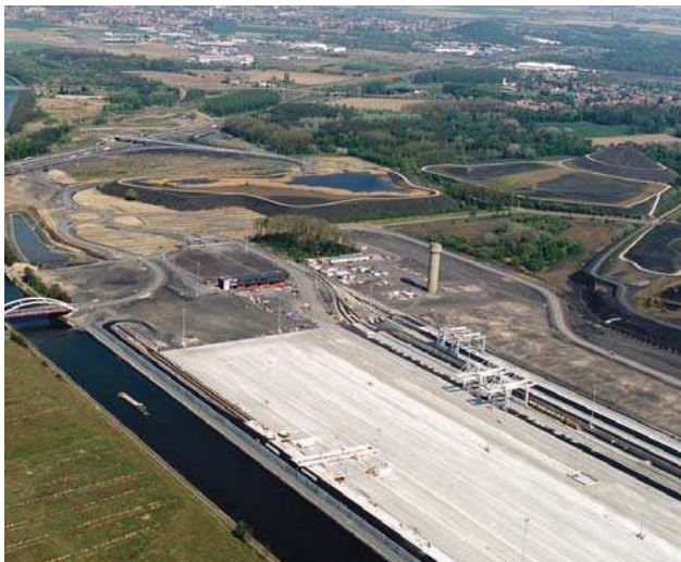
La plate-forme multimodale " Delta 3 " de Dourges (avril 2003).
