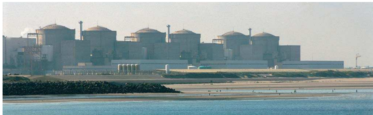
La centrale nucléaire de Gravelines.
