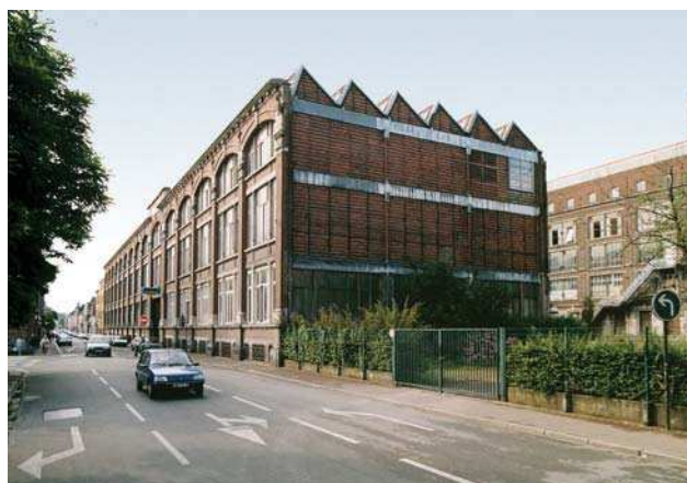
Friche Roussel à Roubaix avant réhabilitation.
